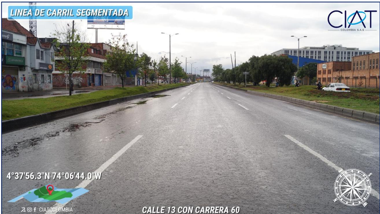
**IMAGEN 9.** En la imagen se aprecia la “Linea de carril segmentada” sobre la calle 13 sentido oriente-occidente.
