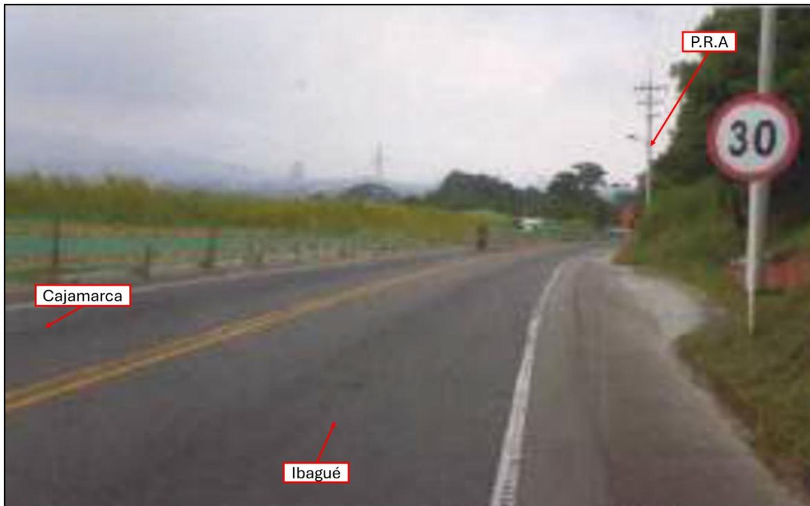
**Fotografía No. 1 Plano General:** En esta fotografía tomada en sentido Cajamarca – Ibagué se aprecian las características generales del tramo de vía donde ocurrió el accidente, la cual presentaba para la fecha de los hechos demarcación de línea amarilla doble continua separadora de carriles, líneas blancas de borde, y señal vertical SR-30 “Velocidad máxima permitida 30 km/h”; nótese el punto de referencia A (P.R.A). En este sentido se desplazaba el vehículo No. 1 Tractocamión.
