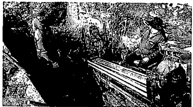
Registro fotográfico 49. Perforación horizontal dirigida para tubería 12"
