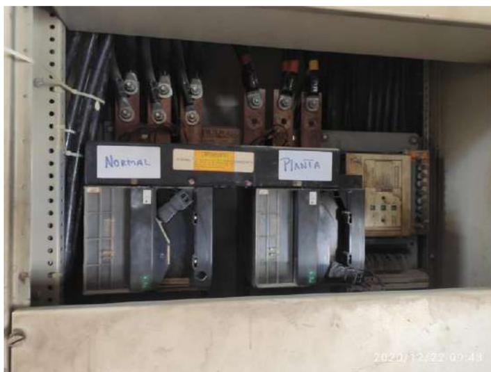
1. Sub estación # 5 sitio del accidente    2. Seccionadores que abren el circuito con el barraje
