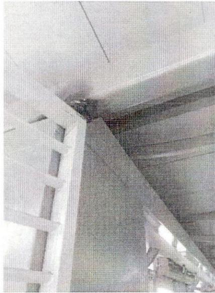
Foto 14: Puntos e soldadura expuestos
