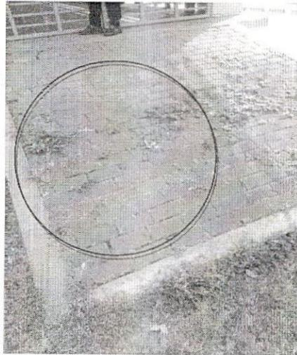
Foto 8: Salida de emergencia segundo Vagón Rampa con hundimiento de adoquín
