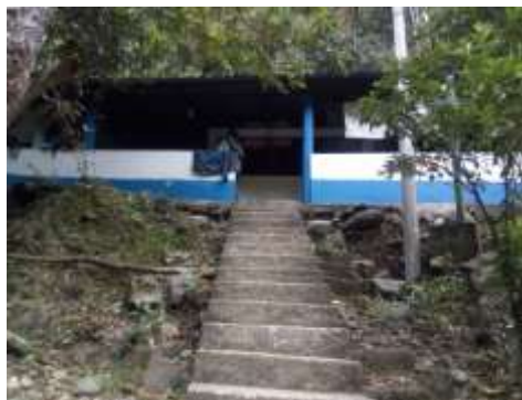
CAMPAMENTO DE TRABAJADORES.
