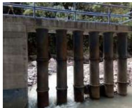
PILOTES DE CONTENCIÓN Y CIERRE.
