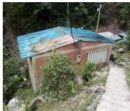
CUARTO DE LA PLANTA ELÉCTRICA.
