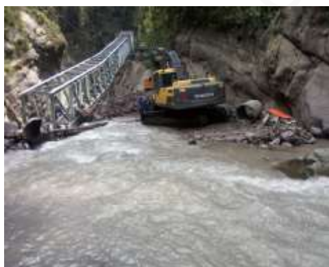
TRABAJOS DE RECUPERACIÓN.
