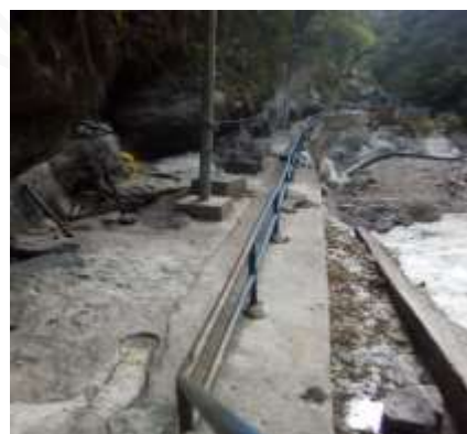
CANAL DE ADUCCIÓN.
