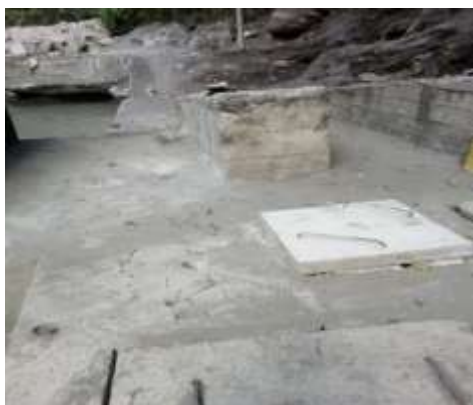
TANQUE SUBTERRÁNEO DE CONTENCIÓN.
