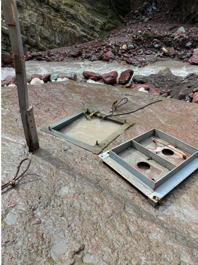
**Imagen 13. Desarenador actual Bocatoma Después de los eventos.**
