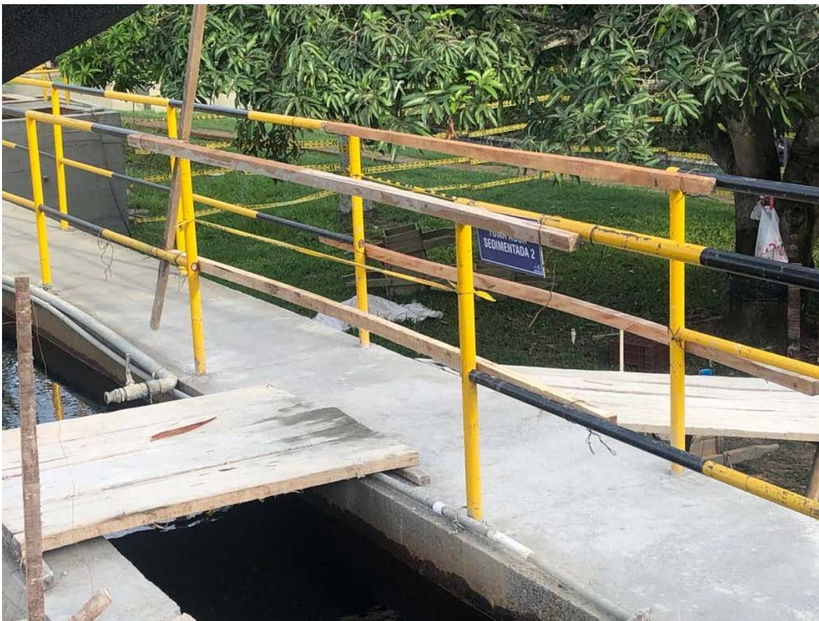
**FOTOS DE LA PLANTA DE TRATAMIENTO AGUA POTABLE DE ZARZAL, CON LAS CUALES SE EVIDENCIA QUE EL ÁREA EN LA QUE OCURRIERON LOS HECHOS SE ENCONTRABA DELIMITADA, AISLADA Y SEÑALIZADA.**
