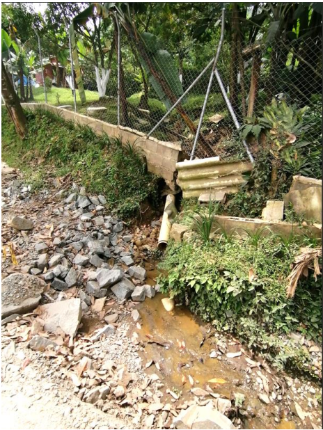
Imagen 9: Tubería de alcantarillado/acueducto desviado hacia la cuneta lateral en construcción.
