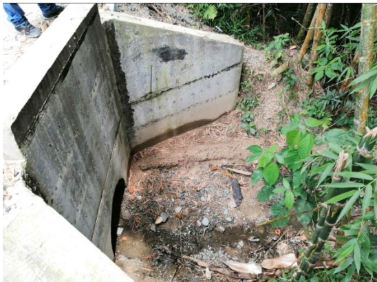
Imagen 6: Tubería de salida y aletas en concreto de la obra transversal 1, donde se evidencia alta colmatación de la obra.
