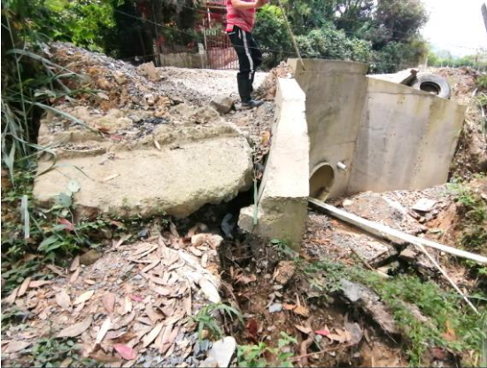
Imagen 14: salida de la tubería con aletas en concreto, donde su base falló y se encuentra inclinada.
