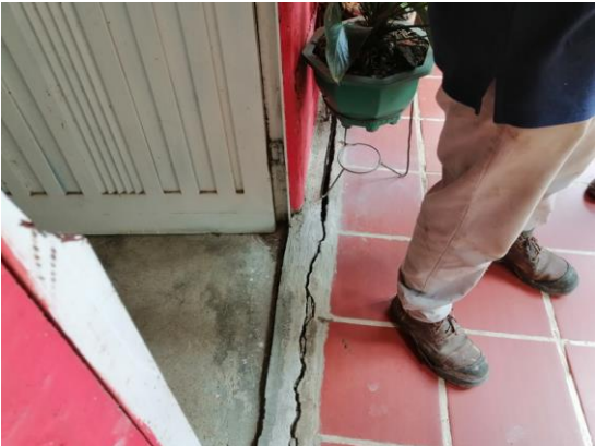
Imagen 16: Separación del andén.
