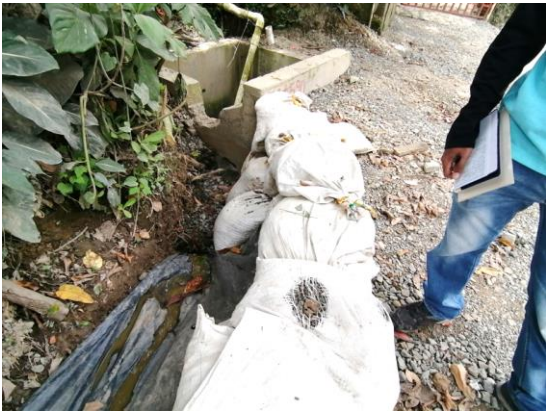
Imagen 12: cuneta que se encuentra en una rasante por debajo de la caja de entrada a la obra transversal
