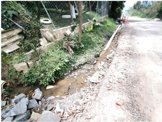
Imagen 10: Cuneta lateral en construcción con problemas de rebose por cota inferior a la caja de entrada, profundidad y ancho.
