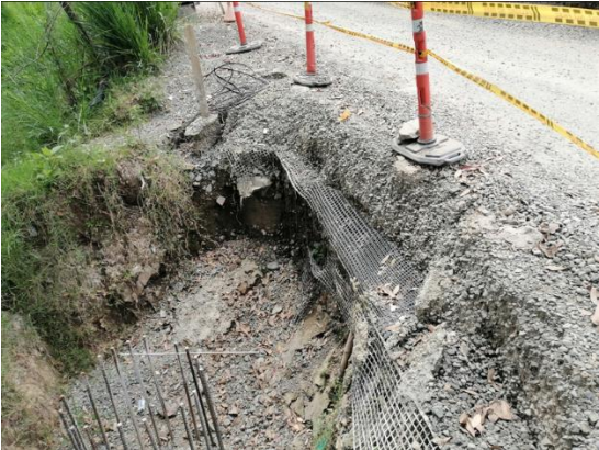
Imagen 7: Perdida de banca de la vía.
