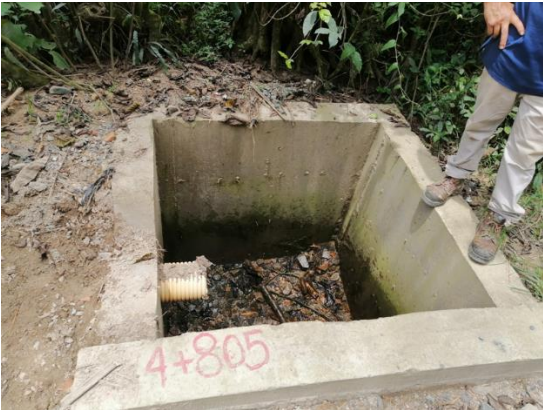
Imagen 5: Caja de entrada de obra transversal 1.
