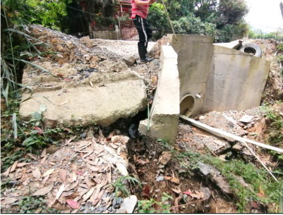
Imagen 14: salida de la tubería con aletas en concreto, donde su base falló y se encuentra inclinada.
