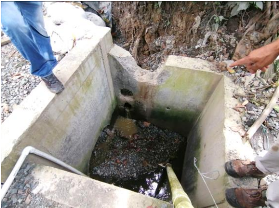
Imagen 13: intervención en una de las paredes de la caja de entrada de la obra transversal sin conseguir el objetivo.
