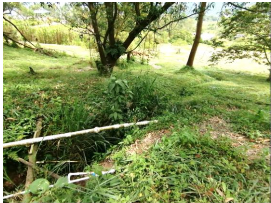
Imagen 15: Canal en tierra donde discurría el agua de la obra transversal, pero esta se encuentra infiltrando colmatando el talud inferior de la vía.
