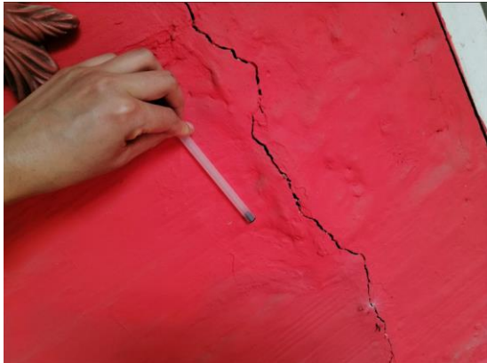
Imagen 17: Grietas en paredes.
