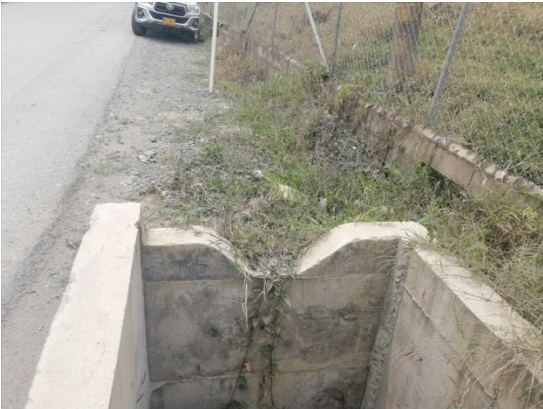
Imagen 18: Obra transversal 3 donde se observa que la vía no tiene cuneta lateral.
