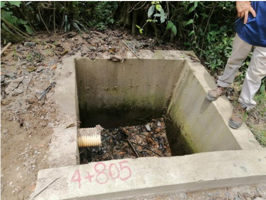
Imagen 5: Caja de entrada de obra transversal 1.
