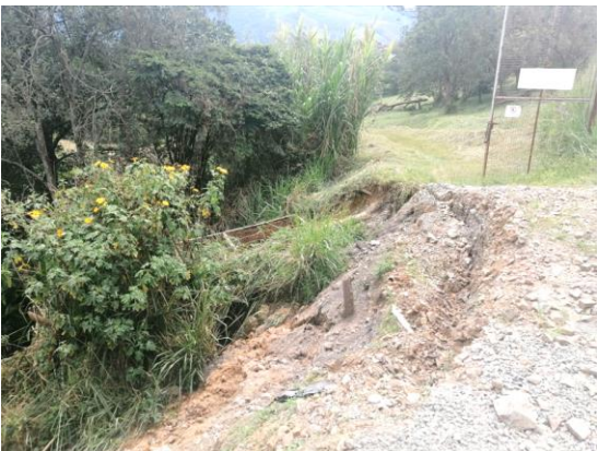
Imagen 28: Socavación y caída de la portería de ingreso al predio La Gualí de EPM.
