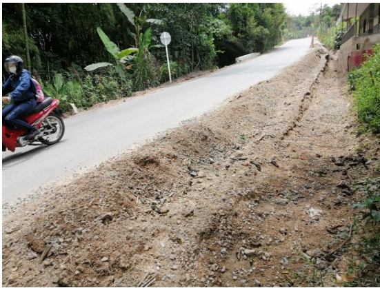
Imagen 4: cuneta en construcción hacia el norte del tramo inspeccionado de la vía hacia Minas.
