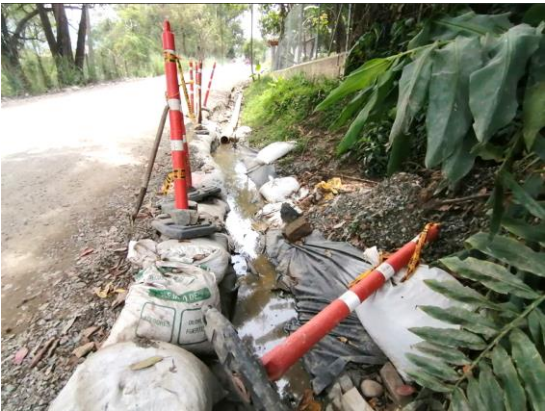
Imagen 11: Dique en costales para compensar temporalmente la falta de capacidad hidráulica de la cuneta lateral.
