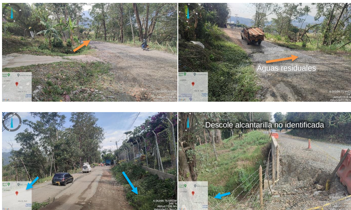
Figura 1.32. Tramo entre Alcantarilla 3 y 4
