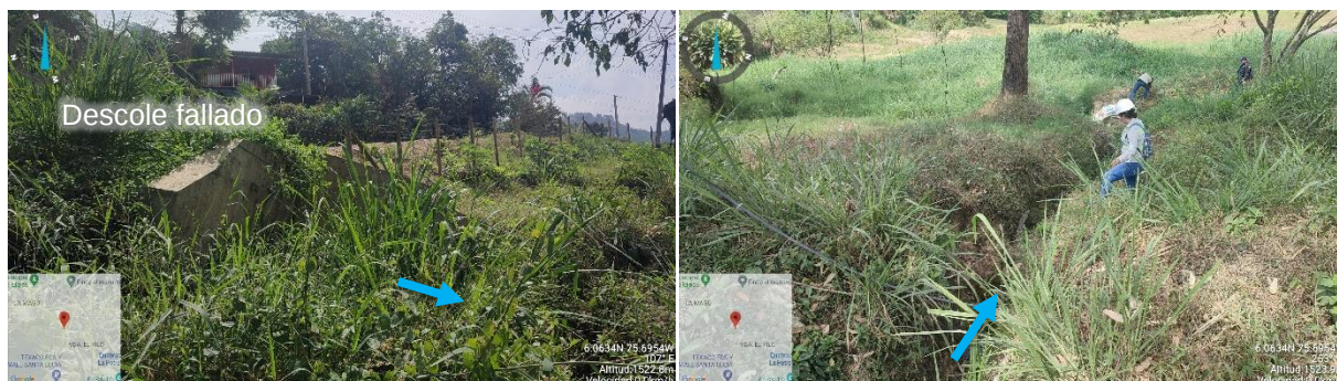
Figura 1.31. Condiciones descarga de la alcantarilla 3
