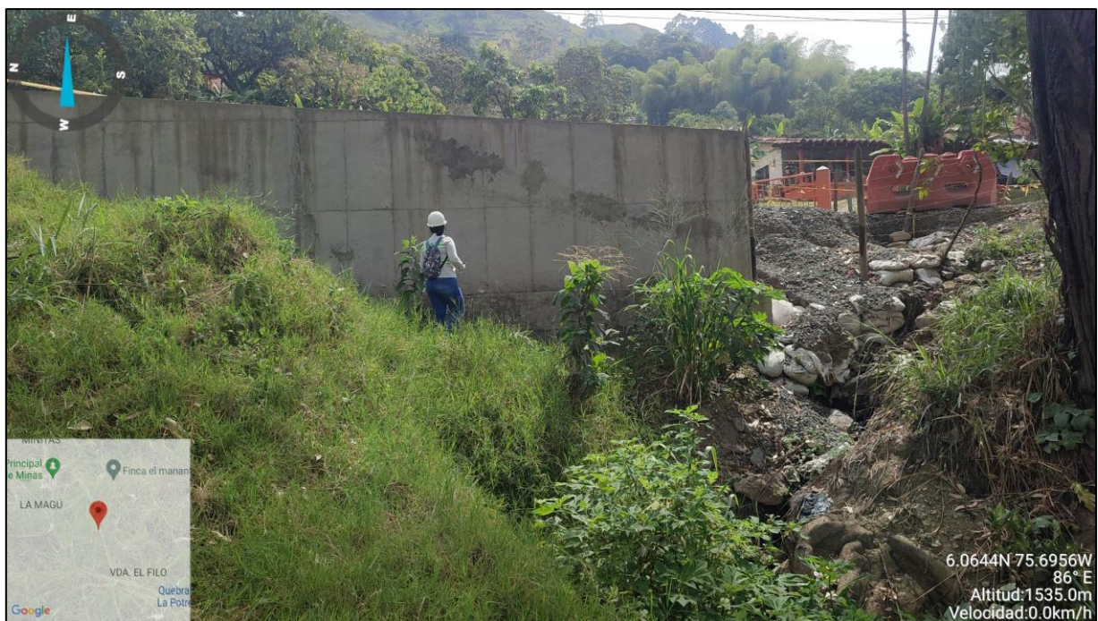
Figura 1.11. Vista frontal estructura de contención
