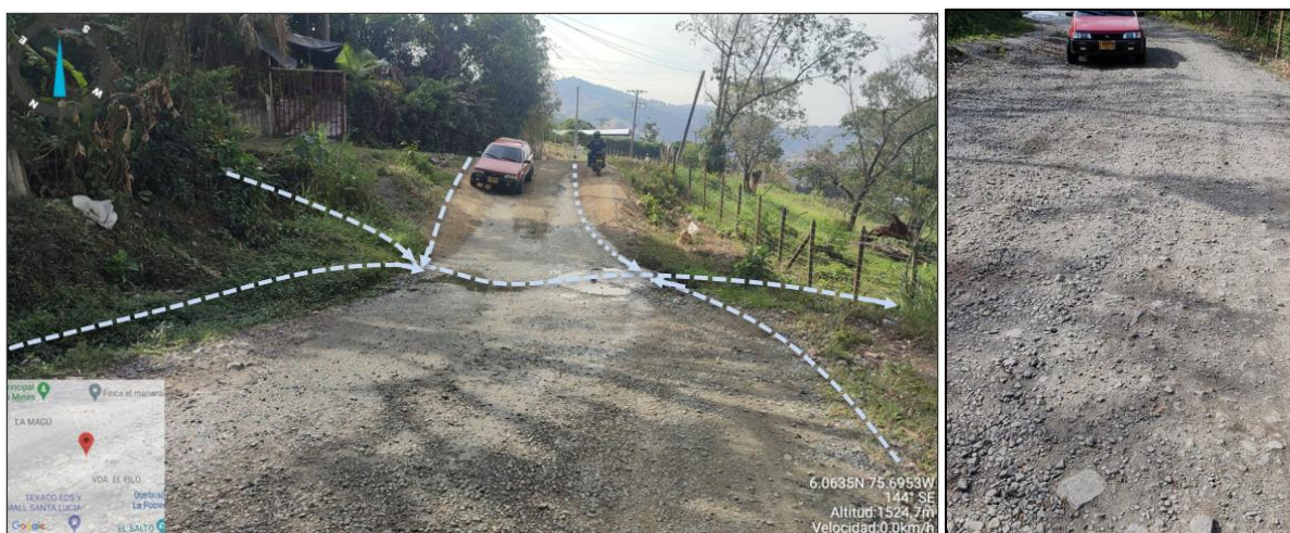
Figura 1.5. Inicio Tramo 2 (160 m). Vía que comunica Amagá y Angelópolis
