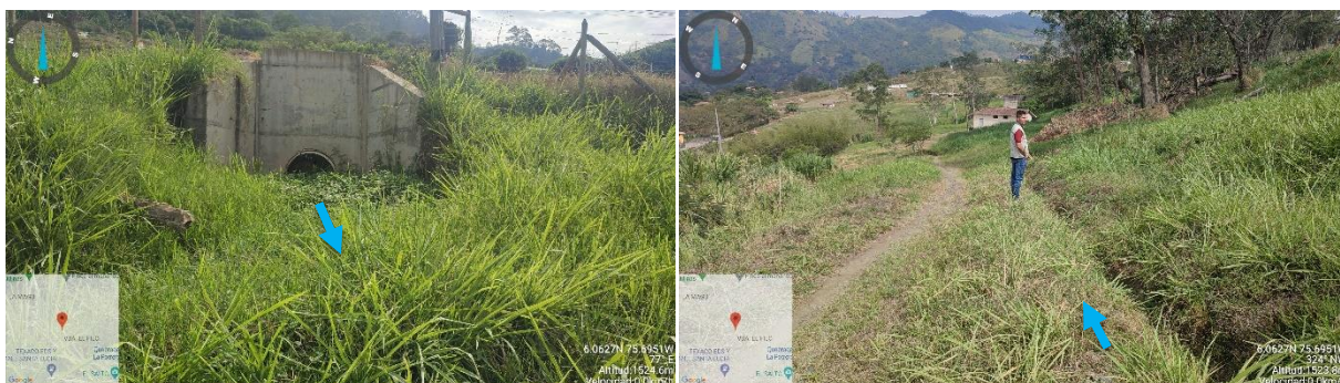
Figura 1.29. Condición de descarga alcantarilla 1 y cunetas a borde la vía de acceso
