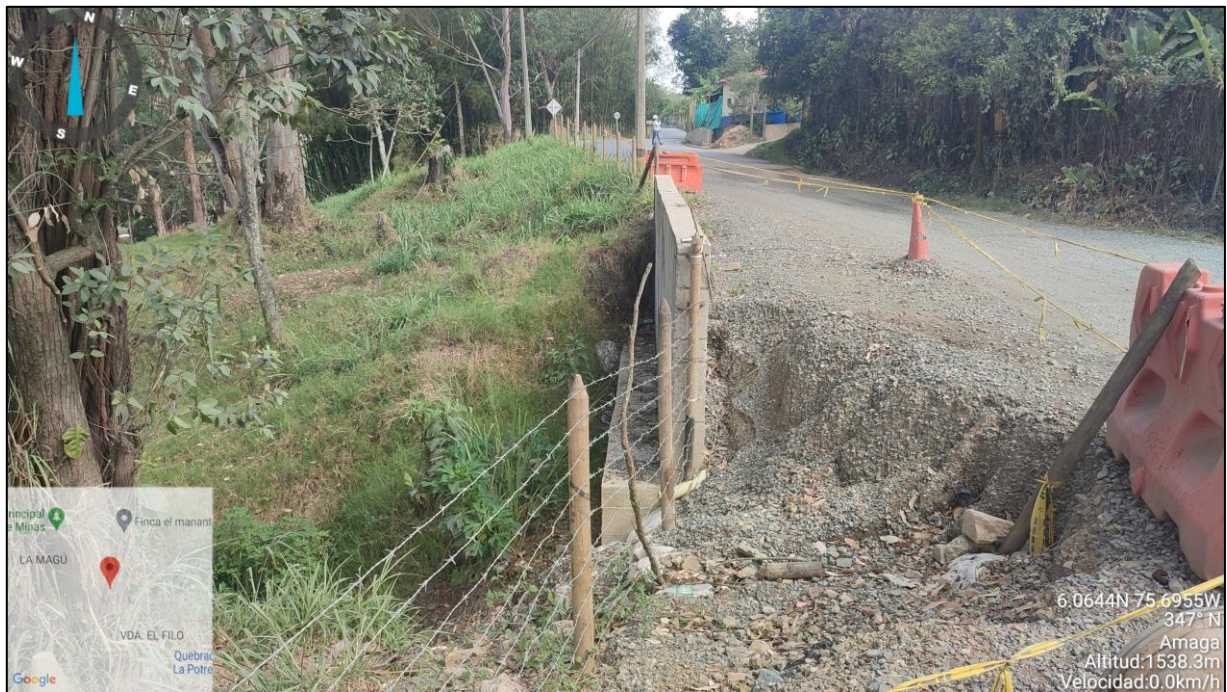
Figura 1.10. Vista lateral de la estructura de contención
