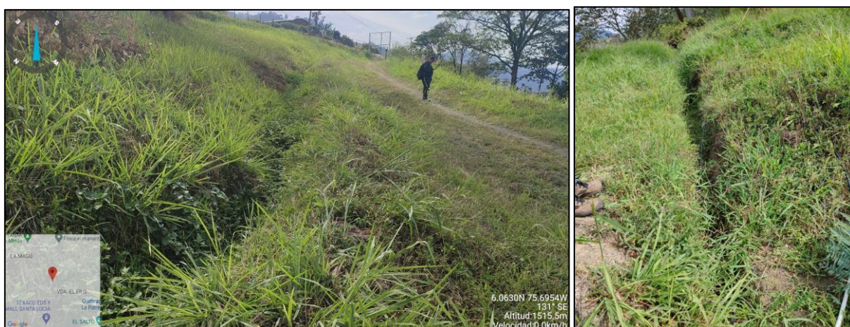
Figura 1.19. Zanjas en terreno natural con cobertura vegetal
