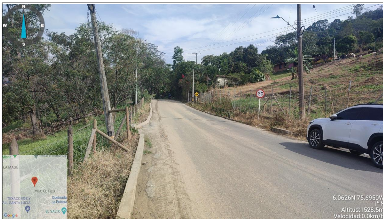
Figura 1.3. Tramo 1 (90 m). Vía que comunica Amagá y Angelópolis
