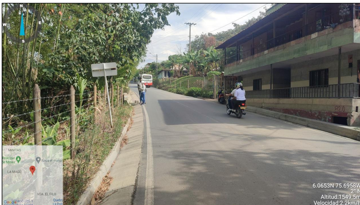
Figura 1.13. Tramo 3 (100 m). Vía que comunica Amagá y Angelópolis
