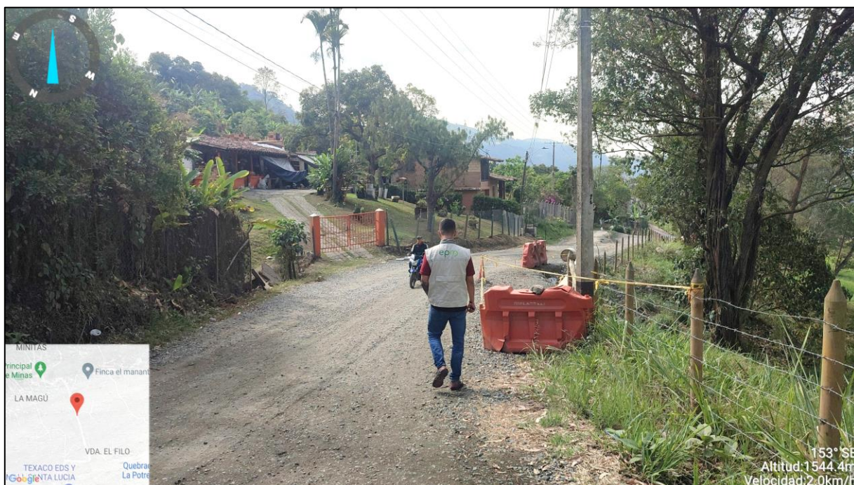
Figura 1.9. Final Tramo 2 (160 m). Vía que comunica Amagá y Angelópolis
