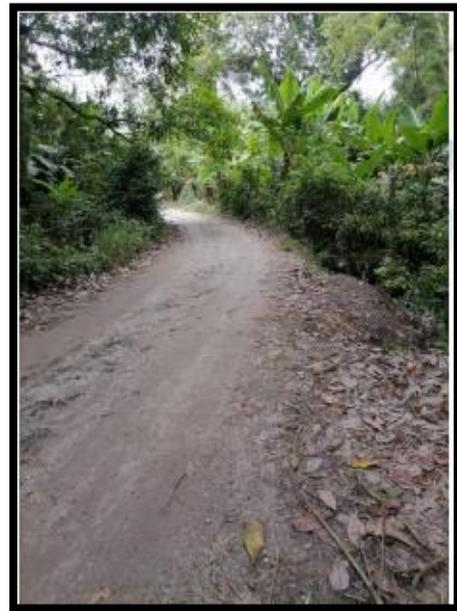
En las imágenes se puede observar la Vereda Montalvo puente de San Bonifacio del Municipio de Espinal – Tolima, observando que se trata de una vía curva, sin pavimentar, regular estado, una calzada, un carril, doble sentido, sin señales de tránsito, vegetación en ambos costados de la vía, sin iluminación artificial.
