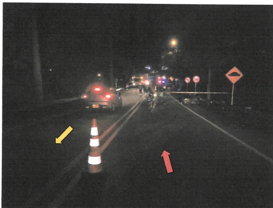
IMAGEN N° 01 FOTOGRAFIA PLANO GENERAL: Imagen tomada en la Vía "Y" de Cerritos - Cauya Km. 10 +500 metros, sector Caimalito jurisdicción del municipio de Pereira (Risaralda), sentido Cerritos – La Virginia, donde podemos apreciar las características de la vía como lo es: Tramo de vía nacional, de una calzada, dos carriles, doble sentido vial, sin iluminación artificial, en asfalto en buen estado, con demarcación vial, doble línea amarilla separadora de carril, línea de borde de color blanco, pendiente, recto, con señalización vertical la flecha de color amarillo indica el sentido vial de Cauya – "Y" de Cerritos, la flecha de color rojo indica el sentido vial de "Y" de Cerritos – Cauya.
