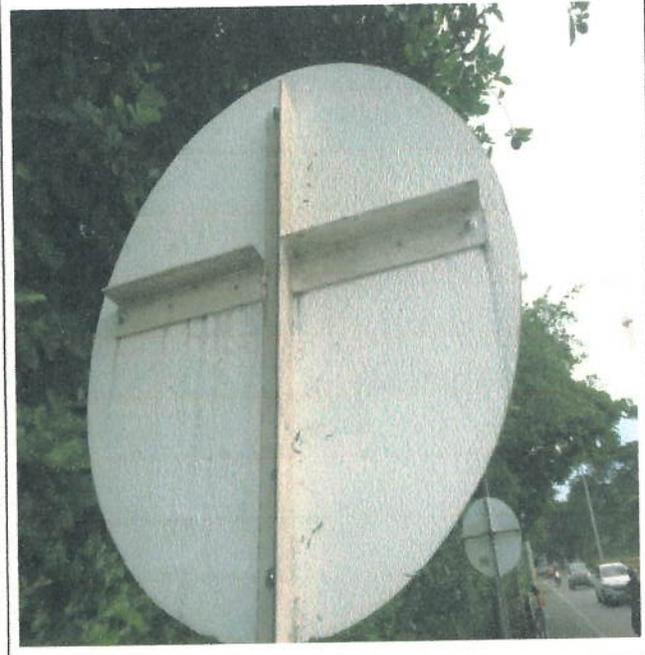
**IMAGEN N°09 FOTOGRAFIA PLANO DETALLE:** Imagen tomada en la Vía "Ye" Cerritos Cauya KM 10+400, sector Caimalito, Jurisdicción de Pereira (Risaralda), donde podemos observar al respaldo de señal reglamentaria SR06 PROHIBIDO GIRAR A LA IZQUIERDA, sin fecha de instalación.
