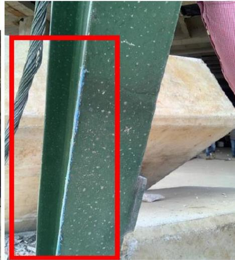
*Vista del punto y rastro de pintura encontrado en la estructura del contrapeso de la torre grúa*
