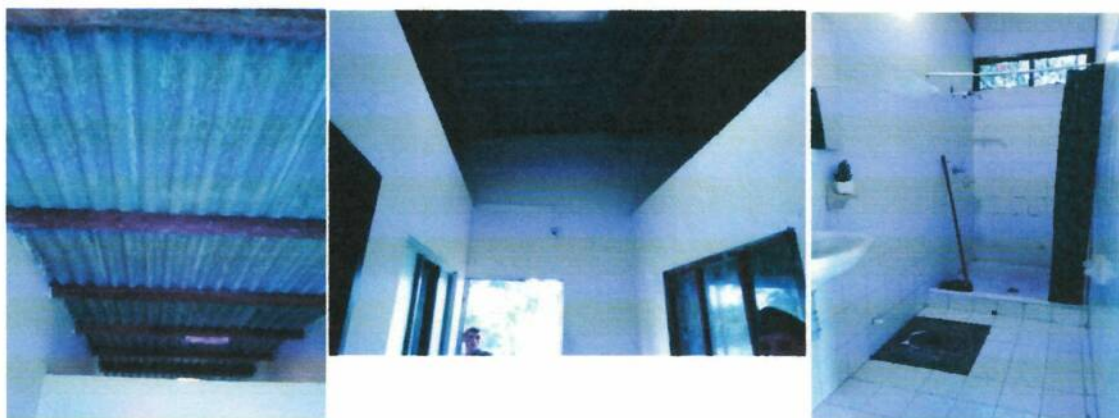
MOSAICO 5: De izq. a Der: Vista interna de la cubierta del recinto de guardia, con vigas de madera; Baño interior del recinto de guardia, sin sanitario.
