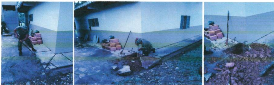
MOSAICO 7: De izq. a Der: Esquina posterior del recinto de guardia seleccionada para excavación; excavación para buscar la cimentación y medición; excavación en el recinto de guardia.
