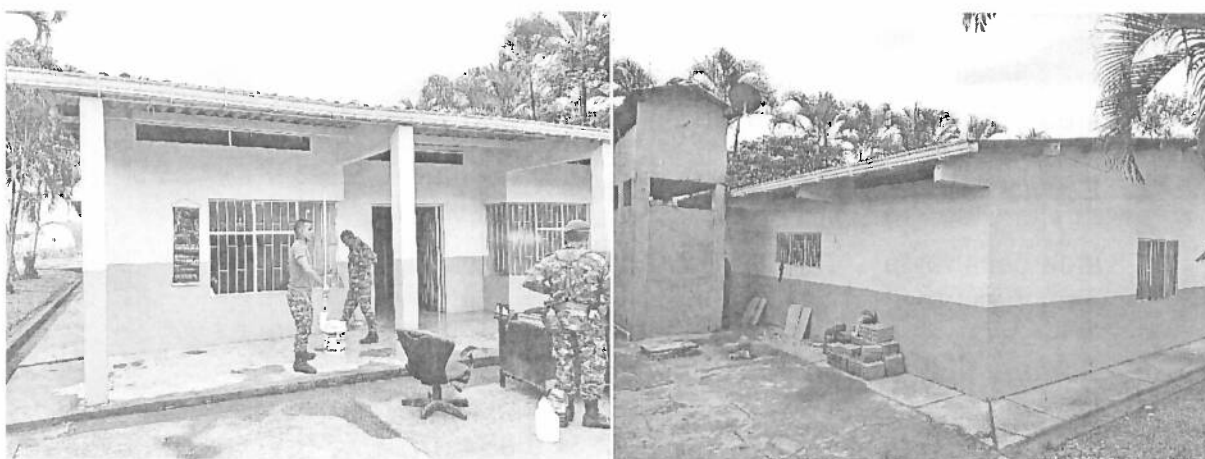
Foto 3. Recinto de guardia y alojamiento, con piso primario y teja en fibro cemento.
