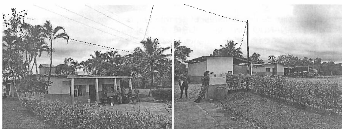
Foto 2. Construcciones convencionales que existían antes de construir los K-SPAN del 2017. A la izquierda se observa el hoy recinto de guardia y alojamiento (antes destinado al puesto de comando del BAEEV No.21 de Puerto Caicedo). A la derecha se observa primero un bloque tipo galpón a dos aguas con piso primario en concreto, cubierta de zinc, donde actualmente funciona una bodega y, segundo está el bloque a dos aguas con piso primario en cemento alisado, cubierta en zinc, donde actualmente funciona un economato.
