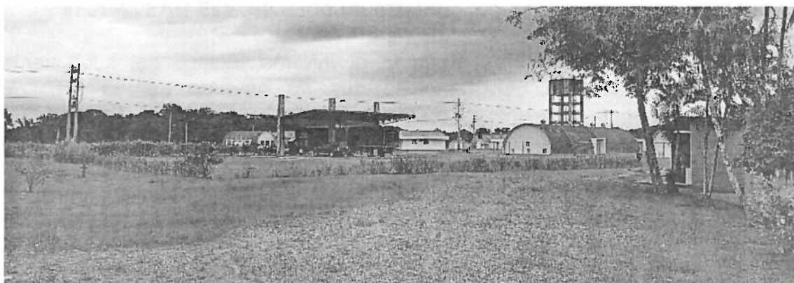
Foto 1. Construcciones nuevas 2017, modernas tipo K-SPAN con cubiertas circular en lámina colaborante.
