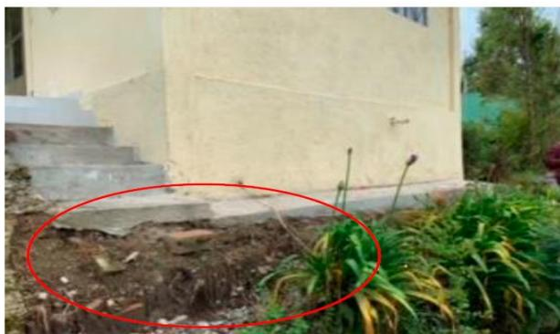
Fotos 8 y 9. En los cimientos de la casa, muros y escaleras, se observa procesos de socavación y hundimiento por humedades. también empozamiento de áreas verdes por el acceso de agua cuando se presentan lluvias fuertes.
