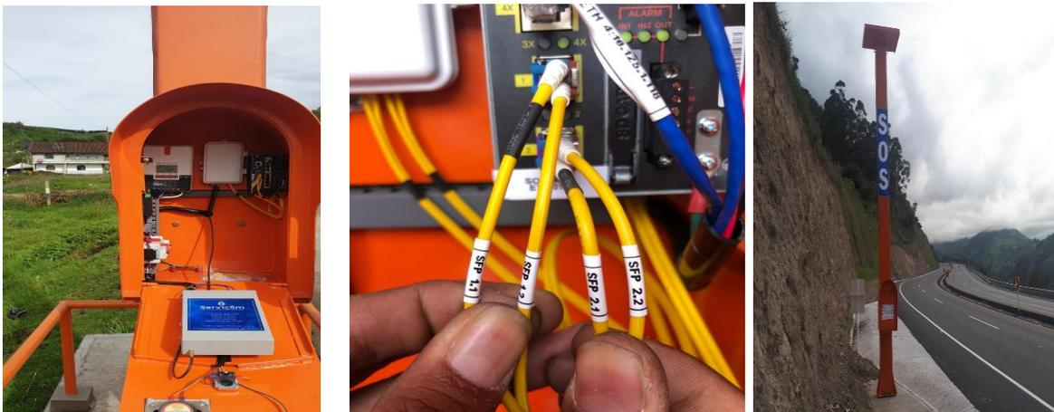
Desntro de las revisiones realizadas al equipamiento de los postes sos, se describen actividades como validacion de marquillado, pruebas de voltaje y carga de las baterias, estado de la logica de control,
