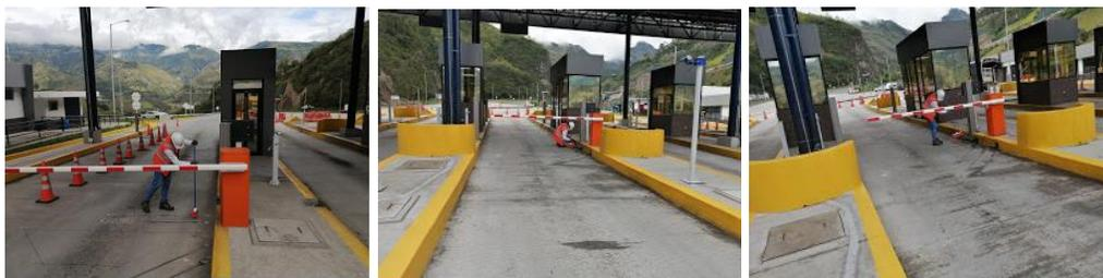
**Cortinas Maps de estación:** En diferentes mantenimientos de los equipos de la estación de peaje, están los sensores ópticos que permiten hacer la diferenciación entre cada paso de vehículos por el peaje, a las cuales se les realiza un chequeo general de funcionamiento, luego se configura la alineación de las cortinas Maps como emisor y receptor dejando en buen estado para buena detección y corte de cada vehículo.
