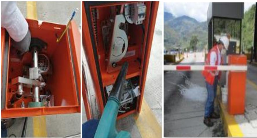
**Peanas cuenta ejes:** Todos estos sistemas utilizan sistemas de detección y preselección de los vehículos que están transitando, en los que genéricamente se utilizan sensores o captadores colocados en el pavimento, que, en función de su situación, indican el tipo de vehículo que circula. Se realiza su mantenimiento diario manteniendo en buenas condiciones para la vida útil y tener buena detección en cada vehículo que transite por la estación peaje placer.
