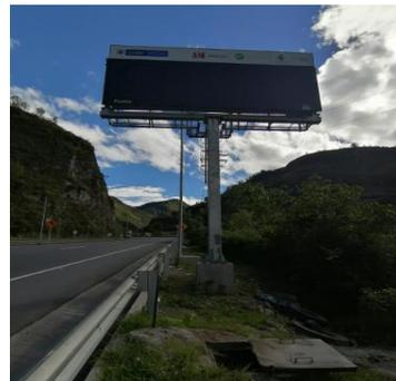
Se desarrollo actividades de configuracion de mensajes en cada uno de los paneles. Se verifico el estado de cada uno de ellos, validando el orden del estructurado y electronica interna, se realiza un mantenimiento externo a los equipos y se hacen pruebas desde el centro de control de operaciones para la implementacion de mensajes
