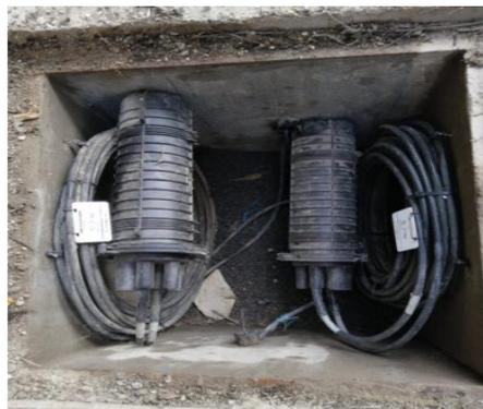
Posterior a ello, se necesita mejorar el marquillado de la red de fibra secundaria (fibra de 8Hilos) para la conectividad de los equipos ITS.
