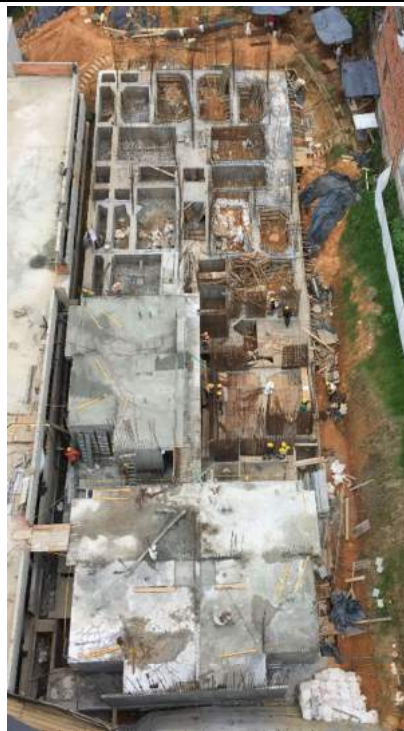
Foto 2. Finalización de vaciados de concreto en vigas y dados de fundación.
