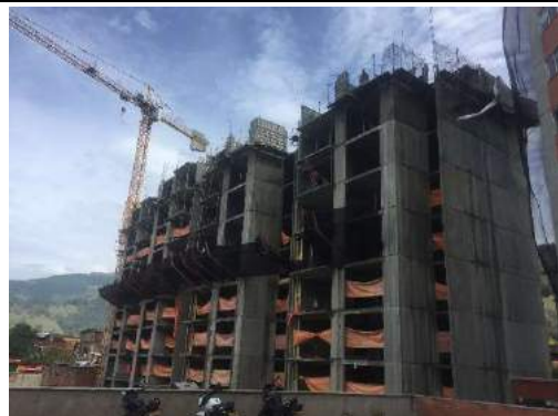
Foto 3. abril de 2019, elevación de estructura, muros estructurales en el N8.
