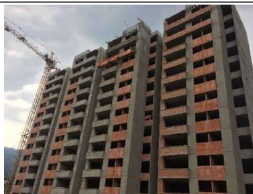
Foto 6. Terminación mampostería e inicio de revocos en fachada, agosto 2019.
