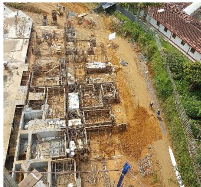
Foto 2. Vaciado de concreto en vigas y dados de fundación de Torre 3.
