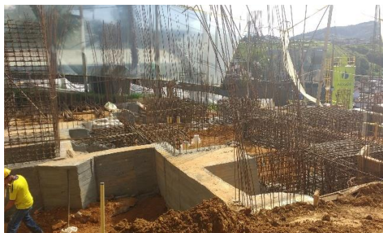
Foto 2. Vaciado de concreto en vigas y dados de fundación de Torre 5.
