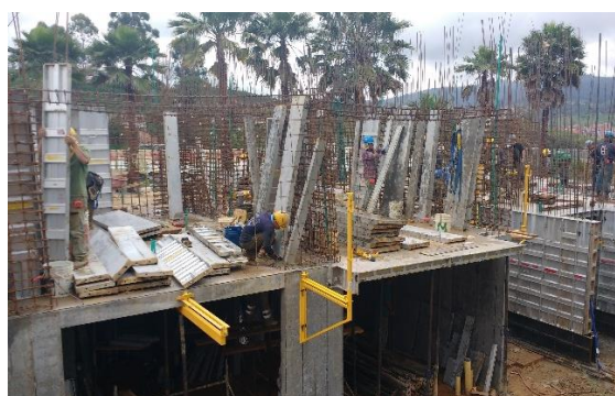
Foto 2. diciembre de 2016, inicio de estructura, muros confinados en N1 y N2.
