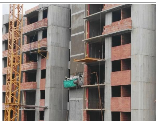
Foto 5. Terminación de mampostería e inicio de revocos en fachada.
