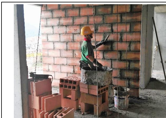
Foto 4. Mampostería interna en apartamentos, ladrillo perforación vertical
