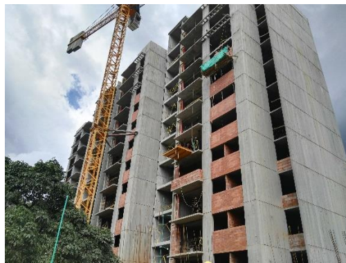
Foto 5. Fase final de la mampostería de fachada en Torre 5.
