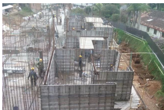
Foto 2. enero de 2017, inicio de estructura, muros confinados en el N1.
