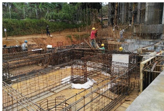
Foto 1. marzo de 2017, acero de refuerzo en vigas y dados de fundación de Torre 3.
