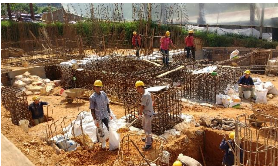
Foto 1. octubre 2016, acero de refuerzo en vigas y dados de fundación de Torre 5.
