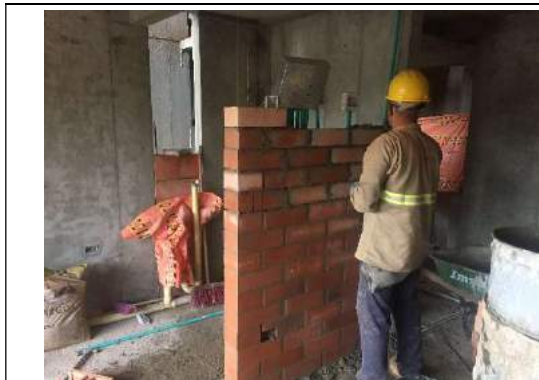
Foto 5. Mampostería interna en apartamentos, ladrillo perforación vertical
