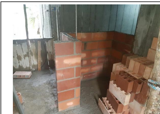
Foto 4. Revisión de mampostería interna, muros con ladrillo de perforación vertical.
