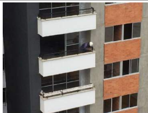
Foto 10. Instalação de pasamanos de varanda em todos os apartamentos
