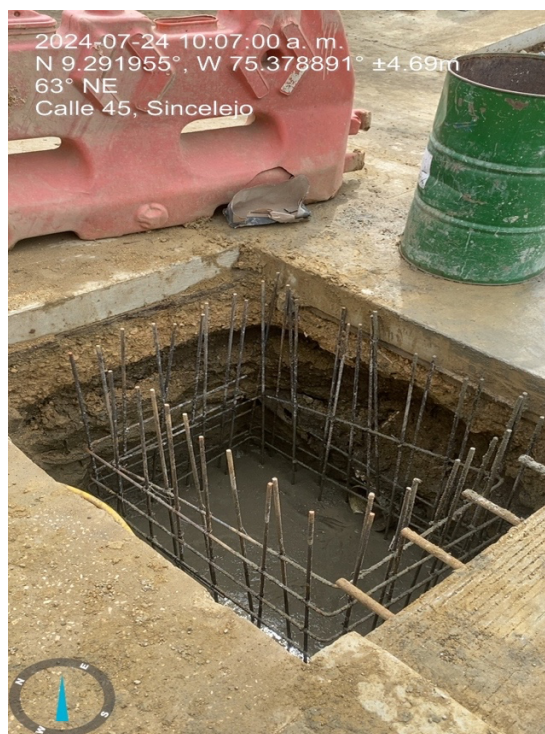
Imágen15: Evidencian obras de registros de alcantarillado pendientes de terminar.
