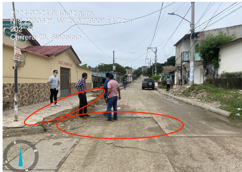
Imagen 5: Punto de inicio de la vía. Terraza sin intervenir. Falta de construcción de andén peatonal y pavimento sin concluir. (ver círculos rojos)
