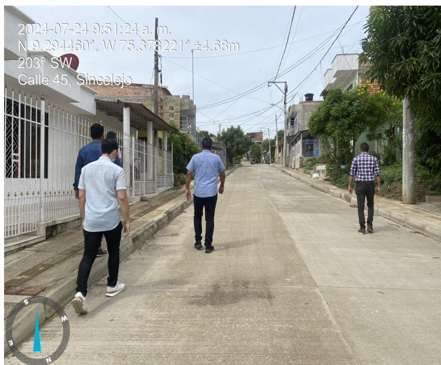
Imagen18: Evidencia falta de señalización vertical y demarcación de la obra.
