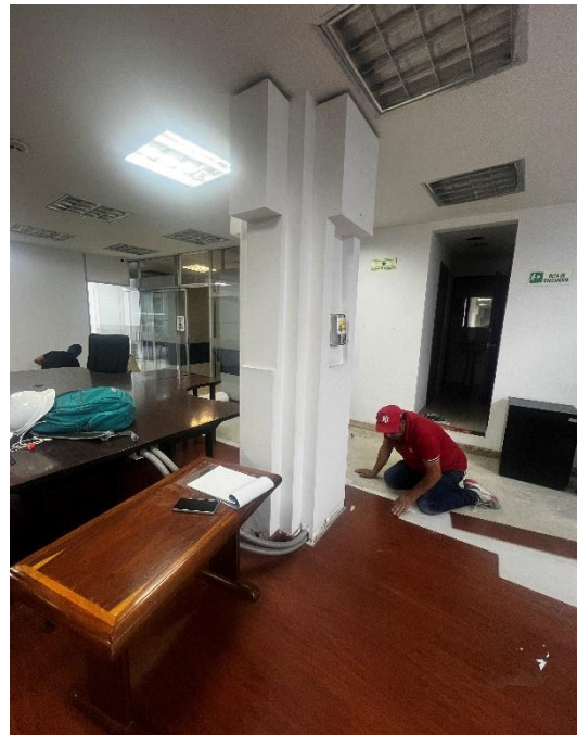
DESMONTE DE PISO LAMINADO
