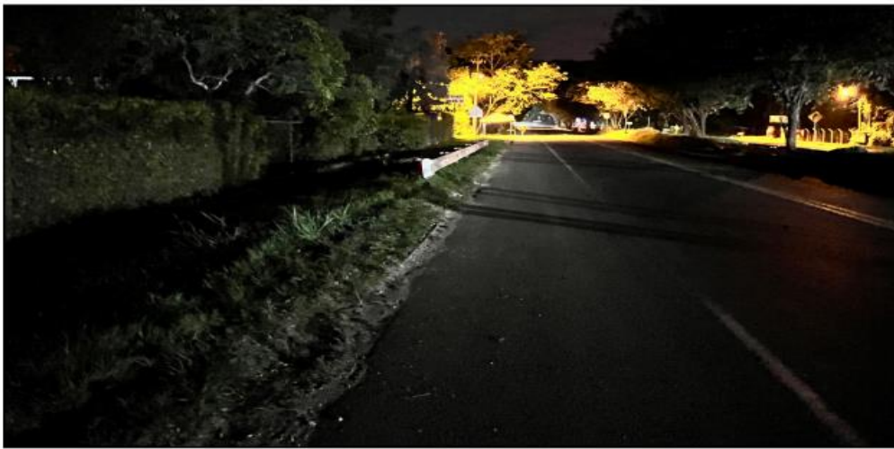
Figura 14. Panorámica de la ruta 40 tramo 05 kilómetro 33 con vista hacia el suroccidente. En el tramo de estudio se observa iluminación en la intersección con la carretera terciaria vía Samaná a Pensilvania, y acceso a varias fincas. Igualmente se observa la iluminación proyectada de La Salle, hacia la berma del costado suroriental de la vía, para el día de la inspección realizada por el suscrito perito entre las 18:30 horas y las 19:00 horas.
