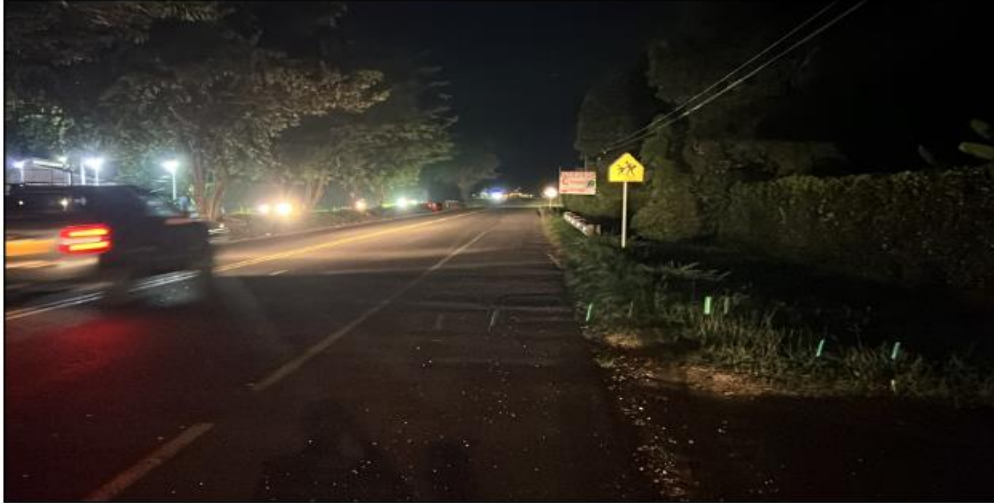
Figura 13. Panorámica de la ruta 40 tramo 05 kilómetro 33 con vista hacia el nororiente en la cual se aprecia únicamente iluminación en el costado noroccidental de la vía en la finca El Reposo De La Salle, iluminación que se proyecta hacia la calzada y berma del tramo en estudio. Igualmente la circulación de vehículos iluminan el sector durante su paso.
