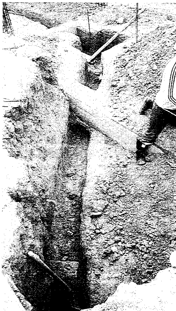
Excavaciones para acometidas sanitaria.
