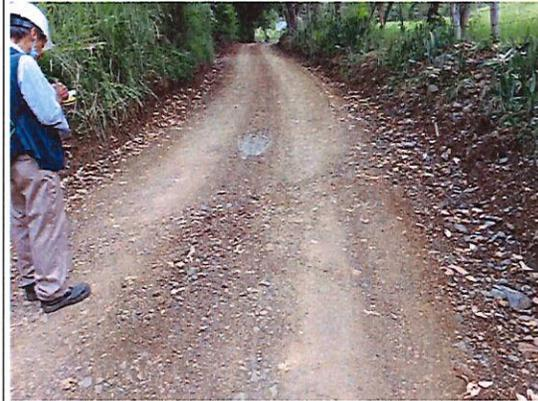
Fotografía No. 16. (noviembre 10 de 2022) vista de tramo de vía estabilizada con geopolímero presenta deterioro superficial por manejo de agua inadecuado (K1+0720 )
