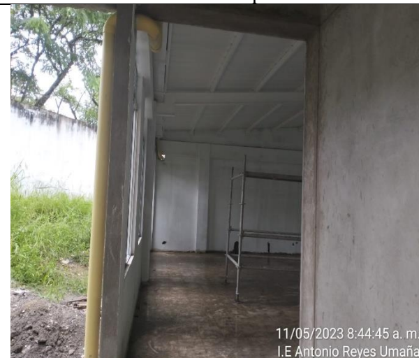
Terminación de instalación final de bajantes e instalación de puertas
