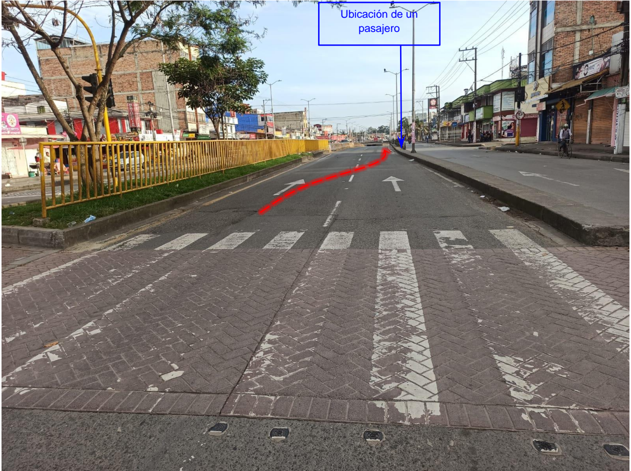
Fotografía N° 3: En esta imagen tomada en sentido Sur-Norte, se observa Carrera 17 (Transversal 9) donde se aprecia la calzada izquierda con los dos carriles de circulación en sentido Sur-Norte, además se observa un paso peatonal, la flecha de color rojo indica la trayectoria y maniobra realizada por el vehículo microbús, quien desde el carril izquierdo pasa al carril derecho con el fin de recoger un pasajero.
