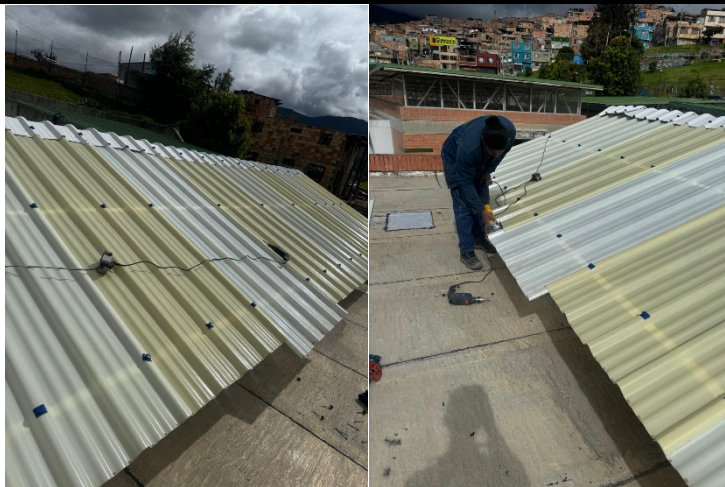
El Cambio de tejas ya fue realizado se está a la espera del recibo por parte de interventoría
