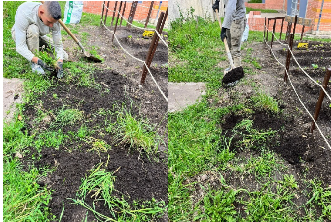
Recuperación zona verde, actividad ya realizada se está a la espera de recibo por parte de interventoría
