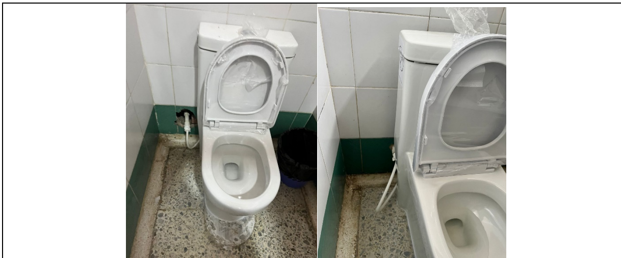
Instalación de sanitarios línea infantil, actividad ya realizada se cambiaron ambos sanitarios a la espera de recibo de interventoría
