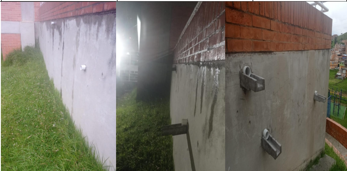
Instalación de gárgolas, actividad ya realizada a la espera de recibo de interventoría
