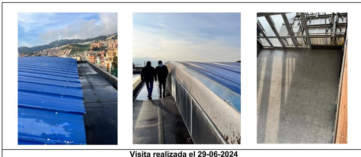
Con relación al evento presentado por goteras en el área de comedor se realizaron reparaciones por parte de personal especializado en cubiertas, donde de acuerdo con el diagnóstico inicial emitido por el estado general de la cubierta termo acústica tipo sándwich de Hunter duglas, compuesta por capa intermedia de fibra de 4 cm, bandeja inferior en lamina cal 22 a tope y bandeja superior en cal 20, grafada por presión con sistema de ajuste mecánico.
