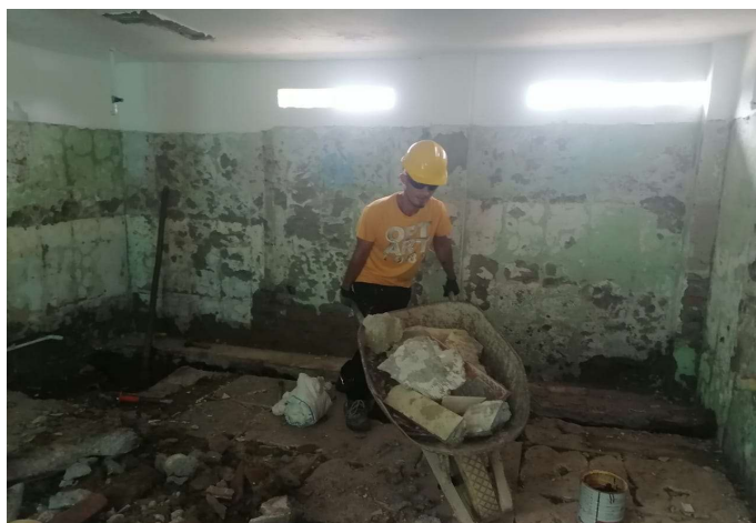
DEMOLICION DE MUROS DIVISORIOS
