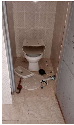
Desmonte de sanitarios, lavamanos, orinales, limpieza y descapote area soportes tanque.
