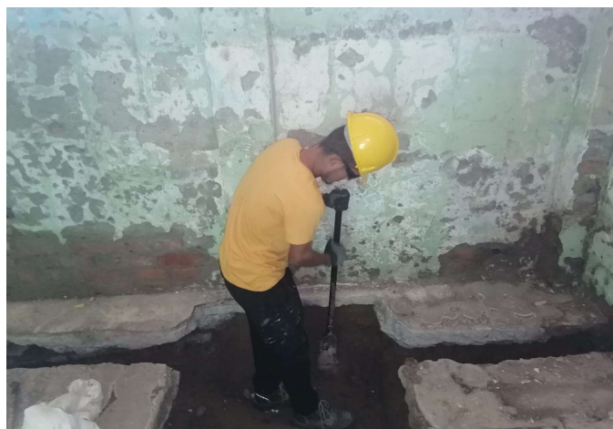
DEMOLICION DE MUROS DIVISORIOS
