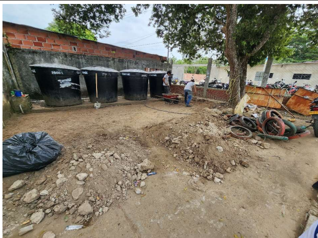
EXPLANEACION Y LIMPIEZA PARA PLACA DE CONTRAPISO
