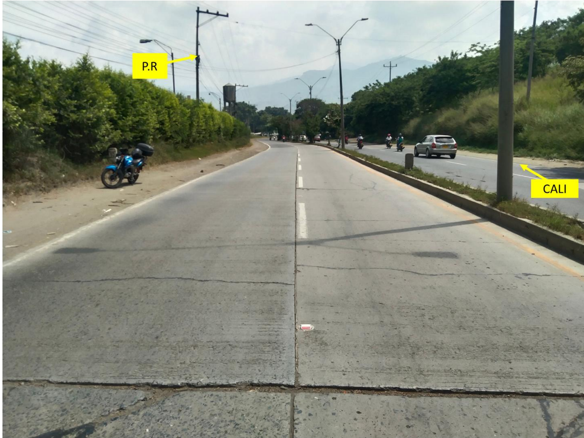
Fotografía No.2 Panorámica elevada : registro en sentido Yumbo – Cali sobre la calzada de la calle 15 que conduce hacia Yumbo, se identifica su morfología general, estado y demarcación.
