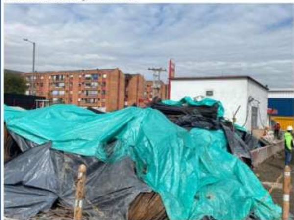
Inadecuada protección en el acero, lo que evidencia un mal manejo de acopios y almacenamientos a cargo del contratista.
