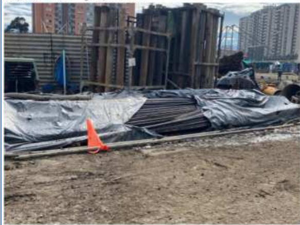
Acero mal almacenado y desprotegido, sumado a que se tienen demasiados puntos de acopio del mismo sin ninguna planeación.
