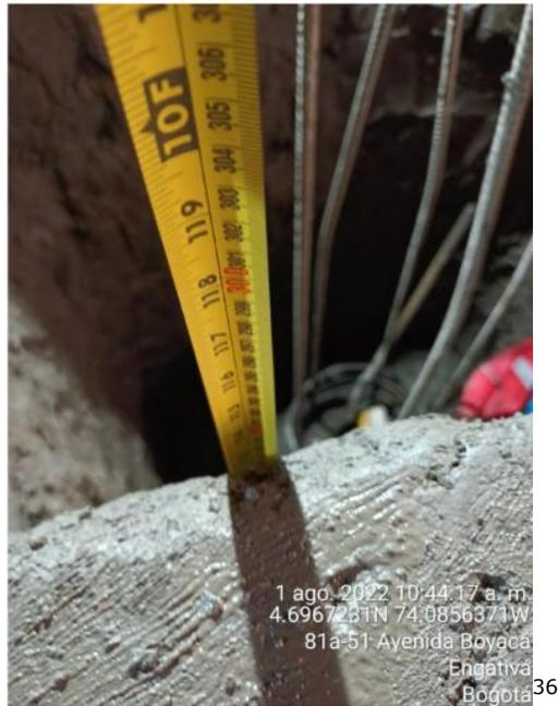
57. El 2 de agosto de 2022 ARPRO requirió a EYT la reparación del Barrete BC-86-C1 que ya había presentado afectaciones en el Sótano no. 1 y que presentó nuevas afectaciones esta vez en el Sótano no. 2, generando un grave riesgo estructural para las placas fundidas sobre este elemento:<sup>37</sup>
