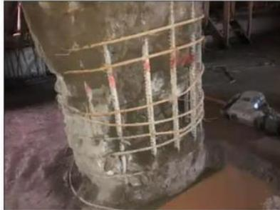
Rta/. Ing. Carlos Palomino recomienda para el pilote 62, vaciar lo más pronto la zona, y como criterio se debe tener en cuenta: a. El pilote puede fallar a compresión, se tiene menos del 70% del área de sección transversal hay que realizar reparación antes de iniciar el amarre de refuerzo. b. Si más del 30% de las barras no tiene concreto sano se puede pandear. Se solicita fundir el concreto del pilote urgentemente en esta zona. No colocar mallas ni nada de peso en Piso1.
