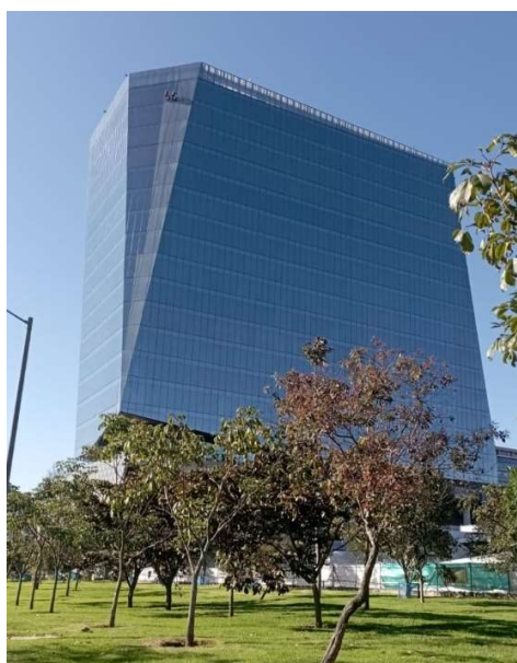
Figura 3. Construcción Parcial del Proyecto Connecta 80 a la fecha actual (septiembre 2024)
