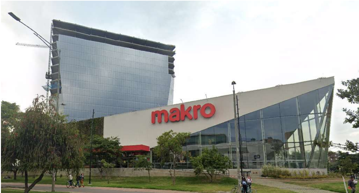
Figura 4. Construcción Parcial a marzo del 2024 Proyecto Connecta 80
