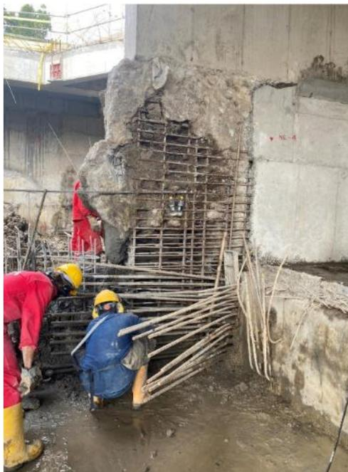
Barrete sin concreto y contaminado en el Sótano no. 1
