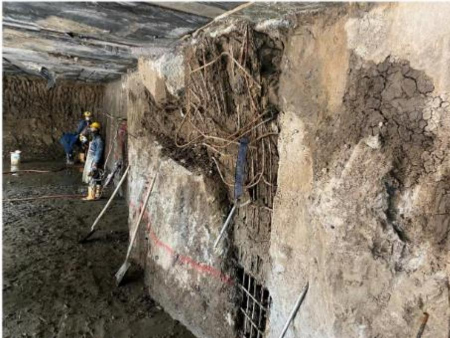
Pantalla Sótano no. 2 área sin concreto y acero cortado
