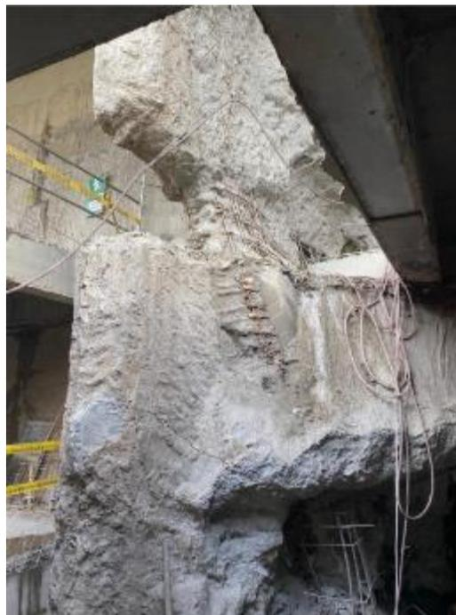
Barrete 17 Ortogonal sin acero y con concreto mal colocado.
