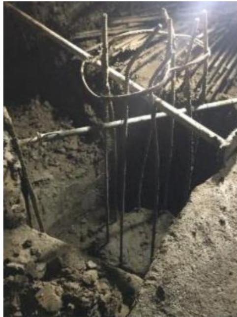
El 1º de agosto de 2022, ARPRO notificó mediante correo electrónico a EYT de un nuevo registro de contaminación en el Pilote 46-01. Ante ello, ARPRO realizó una excavación hasta la cota -15.33m en busca de concreto que cumpliera con los requisitos de calidad preestablecidos, retrasando nuevamente el avance de la construcción del Proyecto.<sup>36</sup> Asimismo, ARPRO adjuntó evidencia fotográfica de los defectos encontrados:
