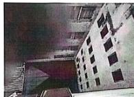
Fotografía No 2 En esta fotografía se puede observar la altura desde la cual cayeron los escombros del desprendimiento del pañete sobre la marquesina que se observa al fondo, reemplando dicha marquesina.
