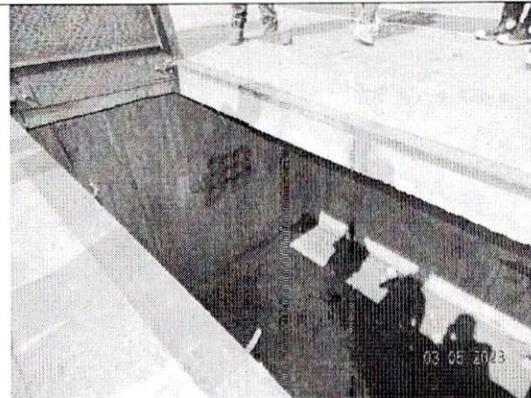
Construcción de cámara de inspección en concreto. Se aprecian 9 ductos para canalización de redes eléctricas
