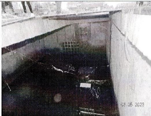
Construcción de cámara de inspección en concreto. Se aprecian 20 ductos para canalización de redes eléctricas
