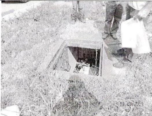
Construcción de cámara de inspección en concreto, para acceso y limpieza de canalización
