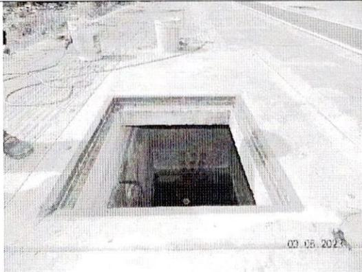
Construcción de cámara de inspección en concreto, para acceso y limpieza de canalización
