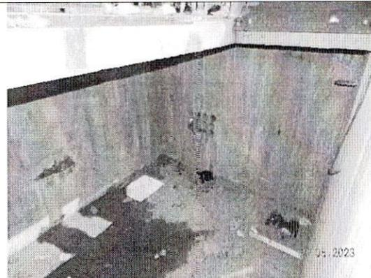
Construcción de cámara de inspección en concreto. Se aprecian 12 ductos para canalización de redes eléctricas
