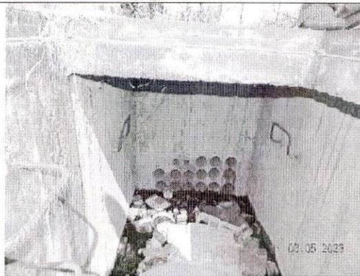
Construcción de cámara de inspección en concreto. Se aprecian 17 ductos para canalización de redes eléctricas
