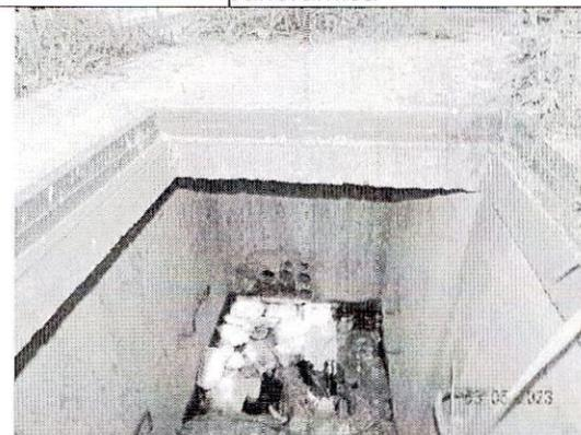
Construcción de cámara de inspección en concreto. Se aprecian 6 ductos para canalización de redes eléctricas
