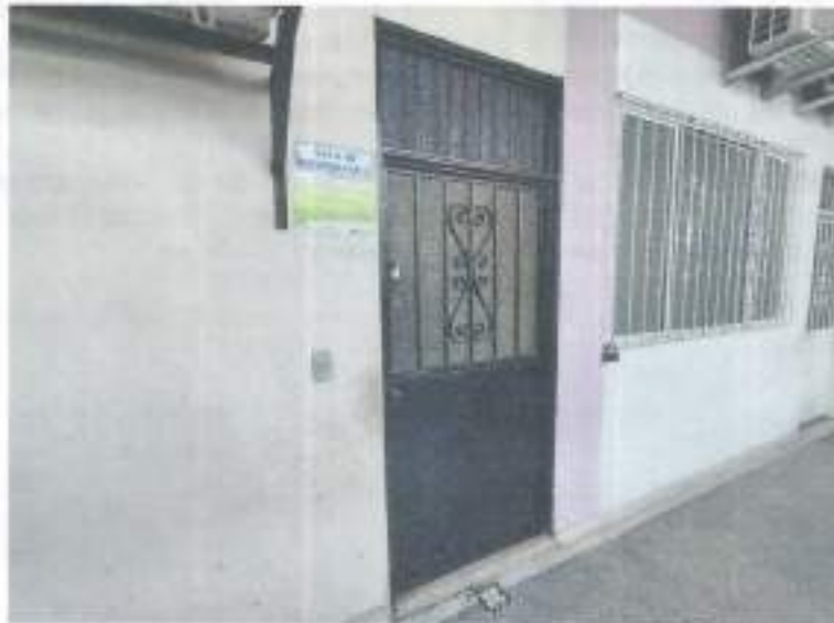
Imagen 5. Ventanas en sede Miramar
