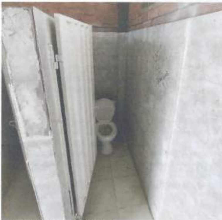
Imagen 17. Sanitario y puerta instalada
