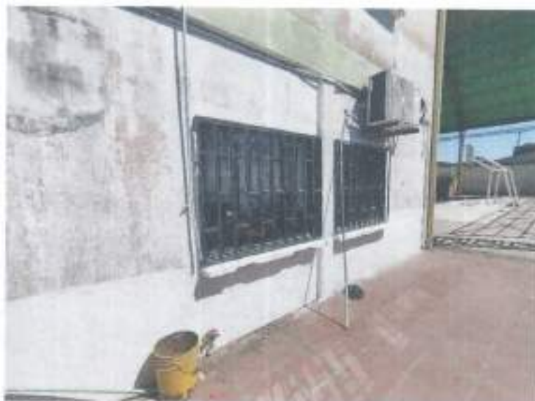
Imagen 14. Ventanas nuevas instaladas
