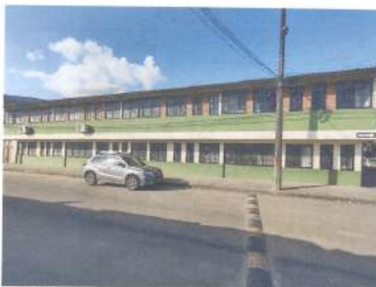
Imagen 6. Ventanas en sede Miramar
