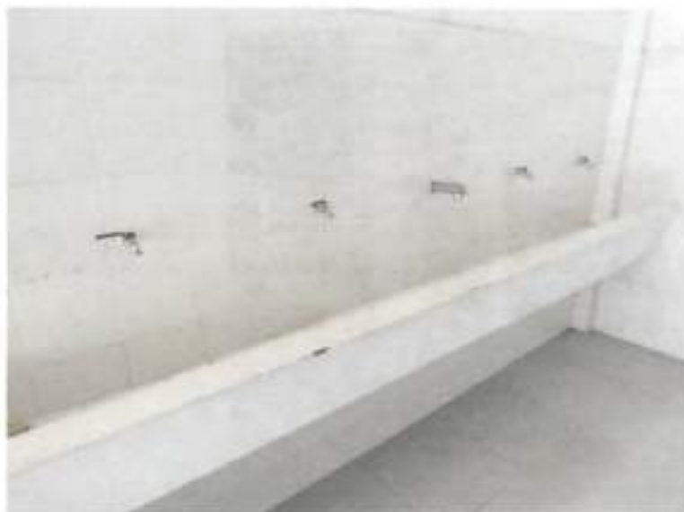
Imagen 12. Instalación de llaves
