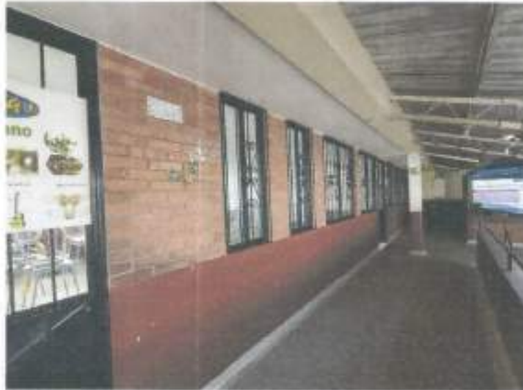
Imagen 4. Ventanas en sede Miramar
