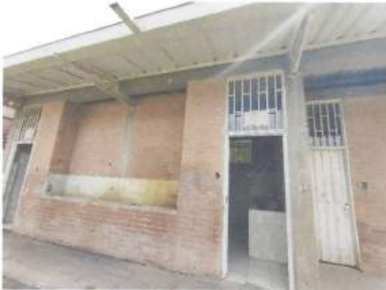
Imagen 16. Batería sanitaria intervenida
