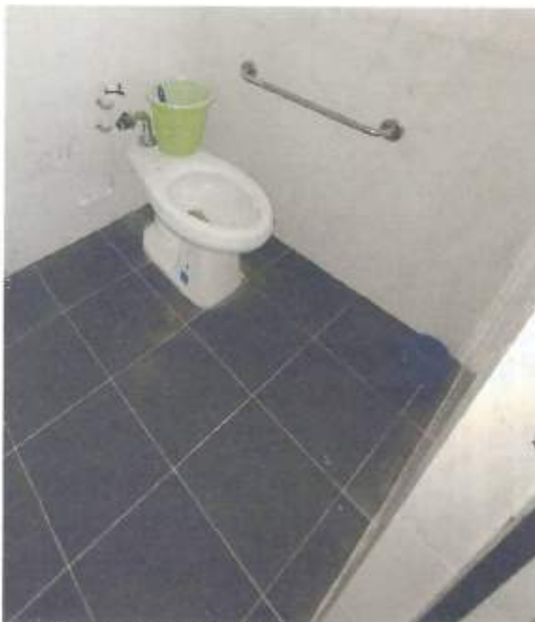
Imagen 9. Elemento sanitario instalado
