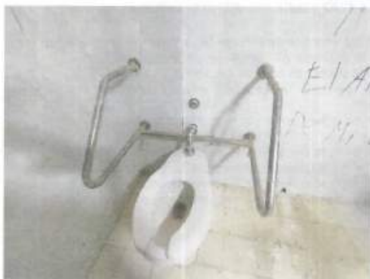
Imagen 11. Unidad sanitaria instalada no funcional
