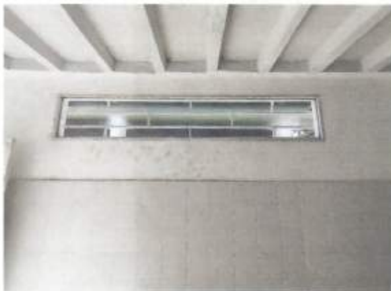
Imagen 13. reja instalada aparentemente
