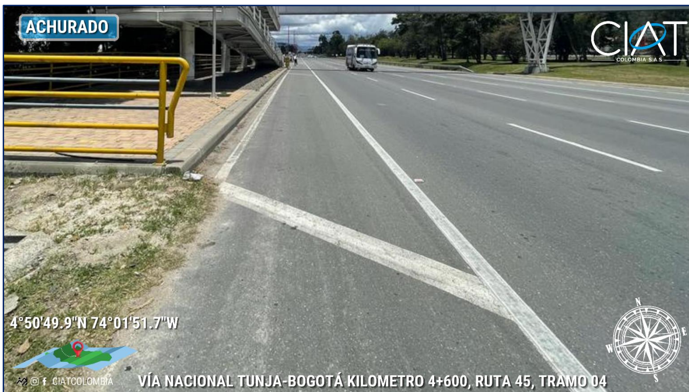
IMAGEN 7. En la imagen se aprecia la demarcación “Achurado”, las cuales se sitúan sobre el lateral occidental de la calzada de la vía nacional que de Tunja conduce a Bogotá en el Kilómetro 4+600 metros.
