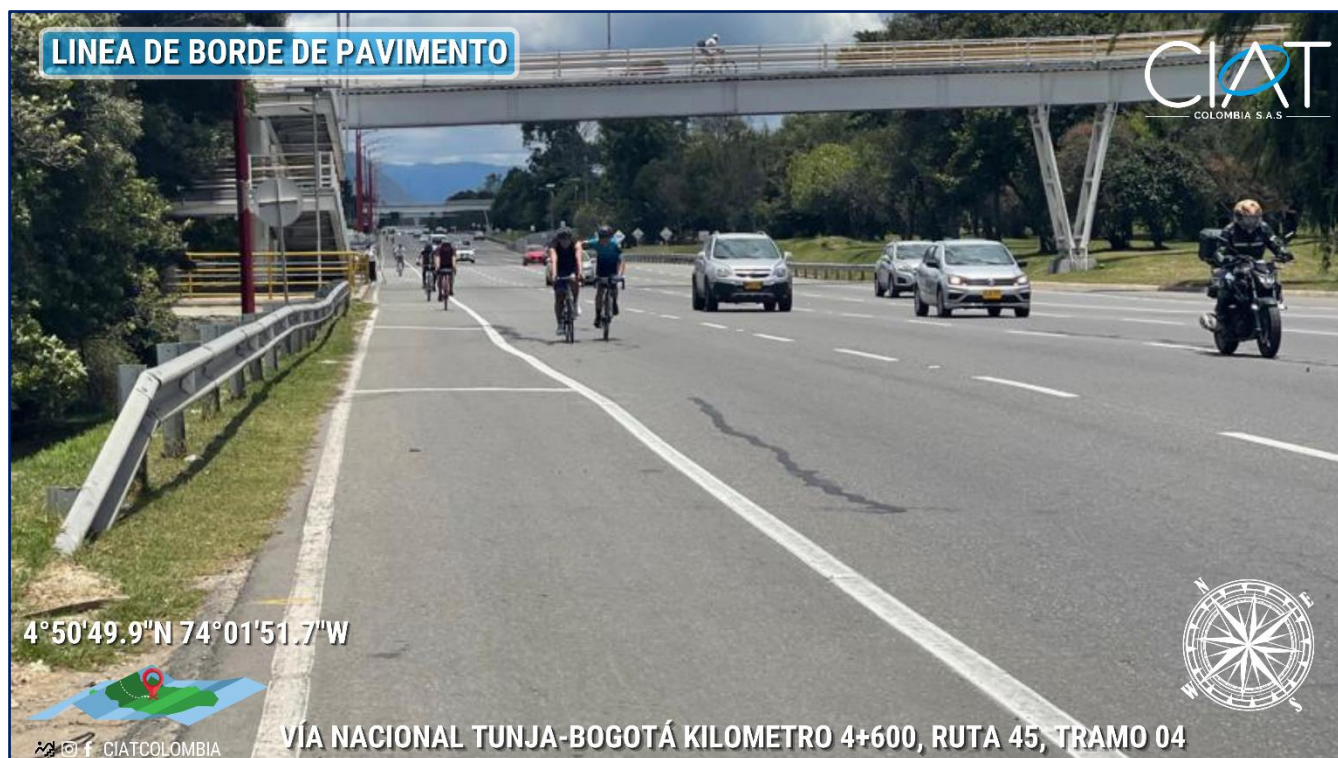
IMAGEN 9. En la imagen se aprecia la demarcación “Línea de borde de pavimento”, las cuales se sitúan sobre ambos costados de la vía nacional Kilómetro 4+600 metros.
