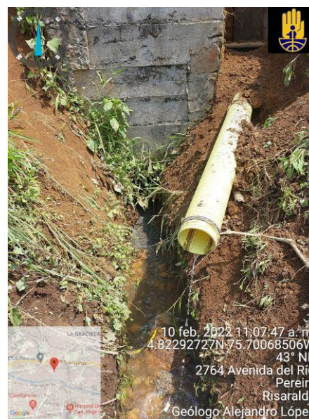
Foto 8. Tubería en PVC que sirve para drenar las aguas de la acequia, para lo cual se rompió provisoriamente esta estructura, de manera que sus aguas descolan sobre la canal de la transversal, la cual no cuenta con un recubrimiento de una capa impermeable que impida los procesos erosivos sobre el terreno.
