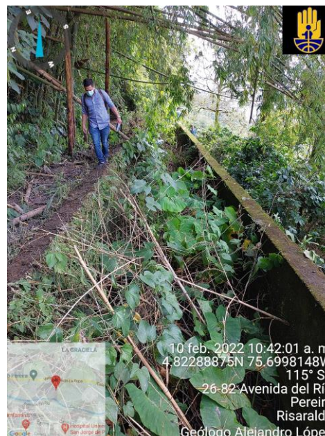
Foto 4. Canal de 2 metros de profundidad por dos metros de ancho, colmatada y con vegetación abundante tipo maleza en su interior.
