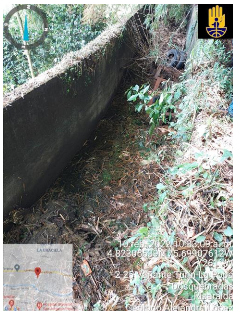
Foto 3. Canal de 2 metros de profundidad por dos metros de ancho, colmatada y con basuras y vegetación abundante tipo maleza en su interior.
