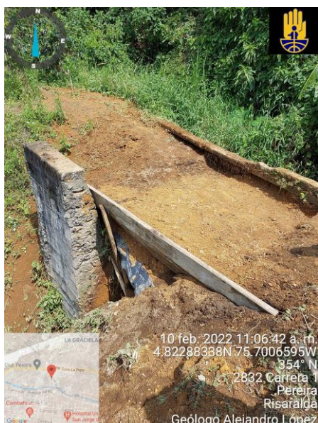
Foto 7. Lleno antrópico efectuado para estabilizar el área alrededor de la transversal y permitir su funcionamiento.
