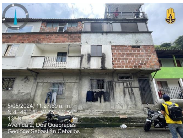
FOT 1. Fachada Norte vivienda manzana K casa 09
