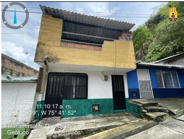
FOT 1. Fachada de vivienda Manzana L Casa 11 Barrio la Esneda Dosquebradas.
