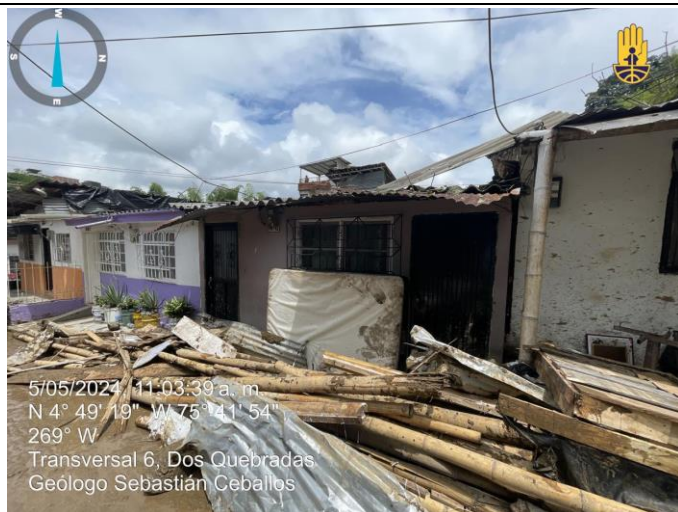
Foto 11. Fachada de la vivienda manzana K casa 12
