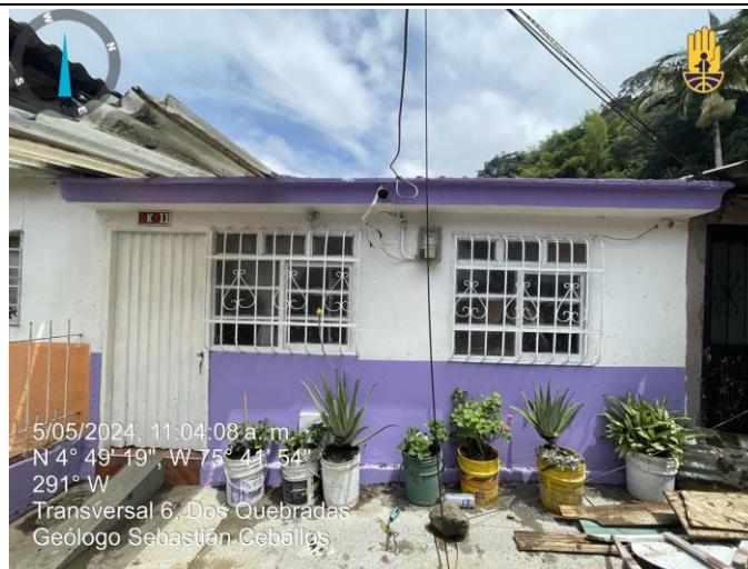
Foto 12. Fachada de la vivienda manzana K casa 11
