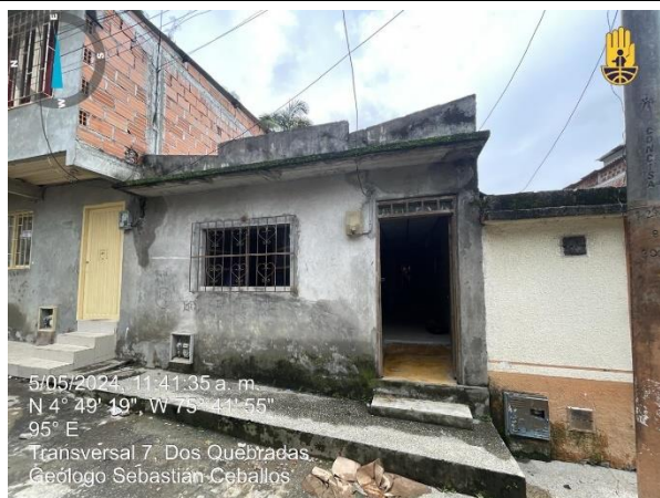
FOT 1. Fachada vivienda Manzana K casa 6 Barrio la Esneda Dosquebradas- Risaralda
