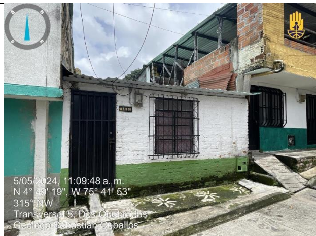
FOT 1. Fachada de vivienda Manzana L Casa 10 Barrio la Esneda Dosquebradas.
