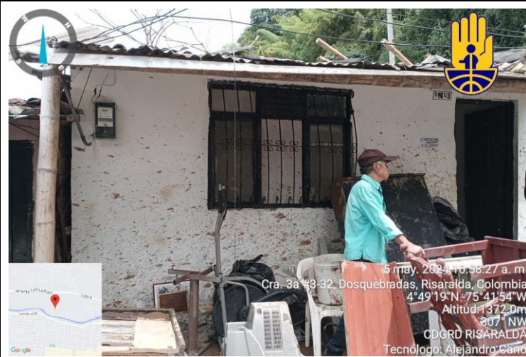
FOT 1. Fachada vivienda mz K casa 13
