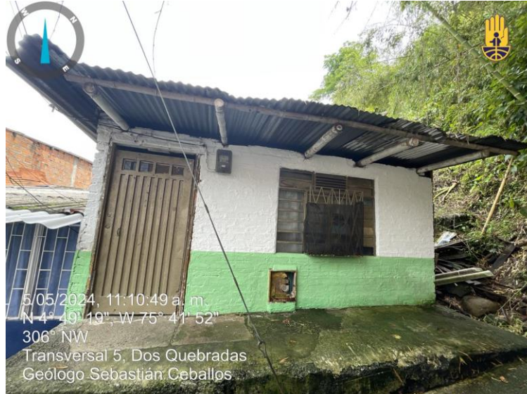
FOT 1. Fachada de vivienda Manzana L Casa 13 Barrio la Esneda Dosquebradas.
