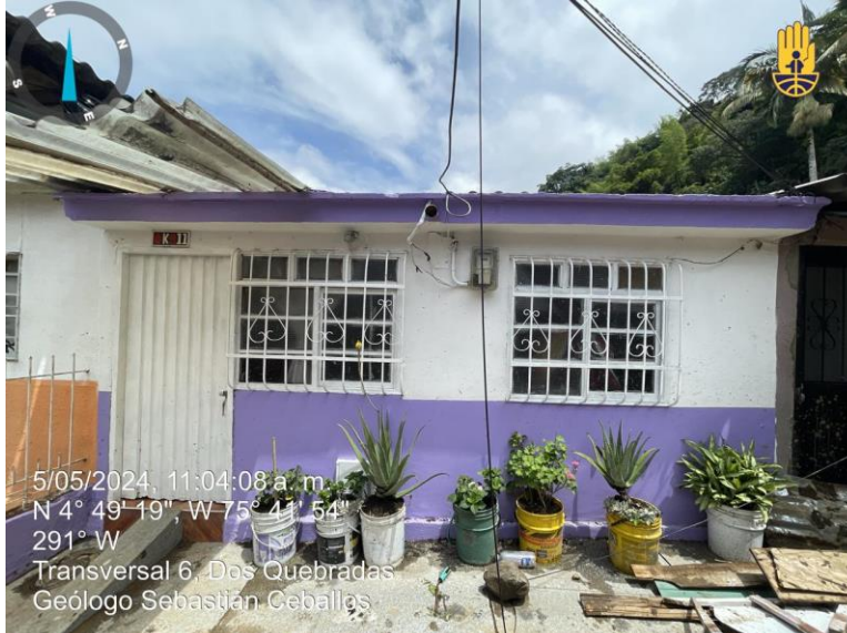
FOT 1. Fachada vivienda Manzana K casa 11 Barrio la Esneda Dosquebradas- Risaralda
