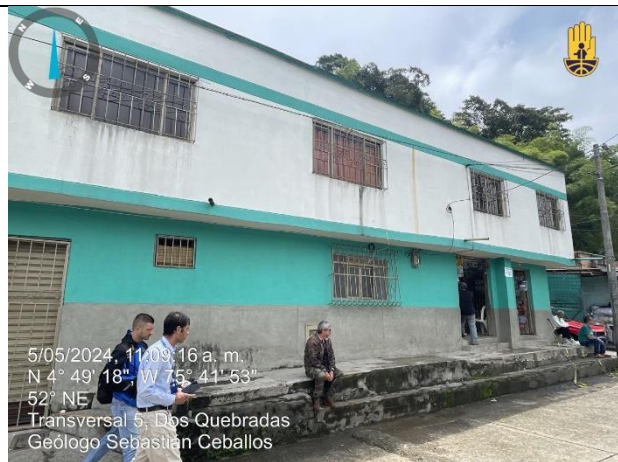
FOT 1. Facha de vivienda Manzana L Casa 9 Barrio la Esneda Dosquebradas.
