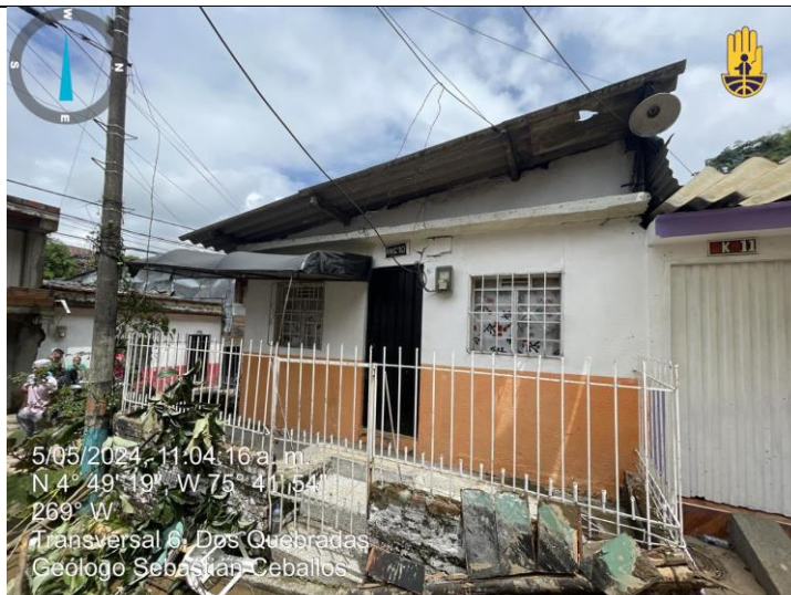
FOT 1. Fachada vivienda Manzana K casa 10 Barrio la Esneda Dosquebradas- Risaralda
