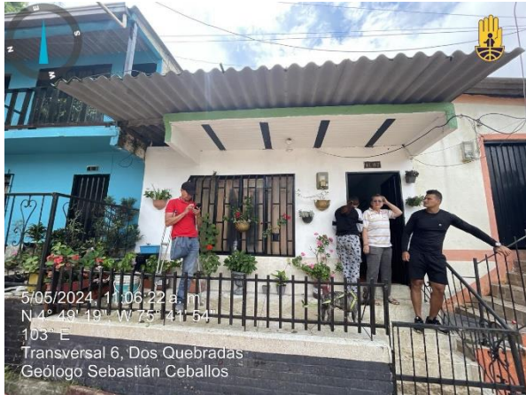
FOT 1. Fachada de vivienda Manzana L Casa 7 Barrio la Esneda Dosquebradas.
