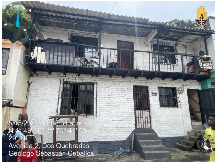
FOT 1. Facha de vivienda Manzana L Casa 8a Barrio la Esneda Dosquebradas.
