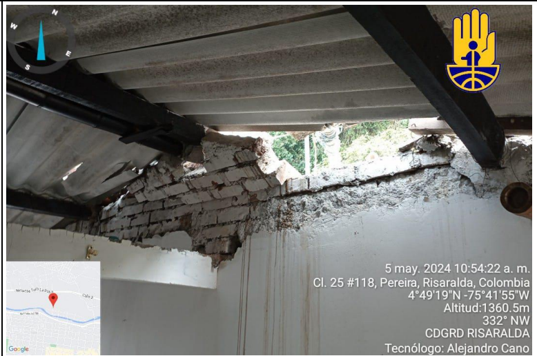
FOTO 2. Interior vivienda mz K casa 13
