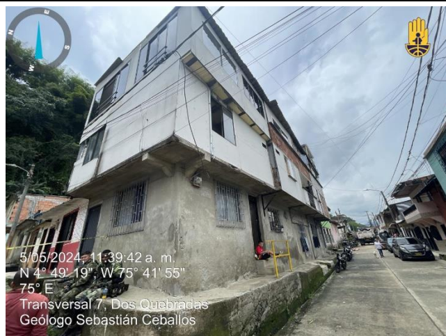
FOTO 2. Fachada Este, vivienda manzana K casa 09
