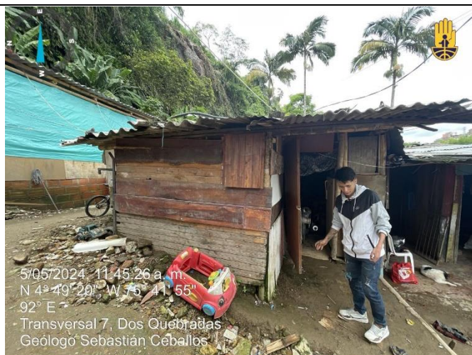
FOT 1. Fachada vivienda Manzana K casa 3 Barrio la Esneda Dosquebradas- Risaralda
