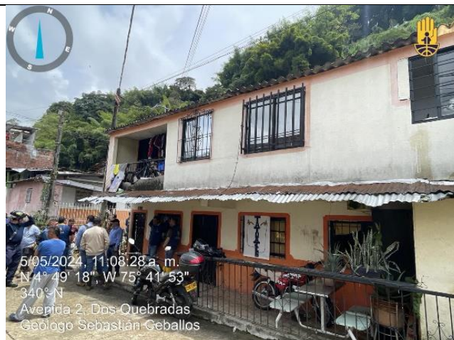
FOT 1. Facha de vivienda Manzana L Casa 8 Barrio la Esneda Dosquebradas.
