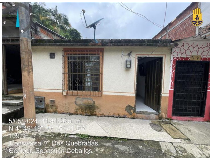
FOT 1. Fachada vivienda Manzana K casa 7 Barrio la Esneda Dosquebradas- Risaralda
