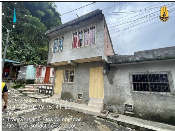
FOT 1. Fachada vivienda Manzana K casa 5 Barrio la Esneda Dosquebradas- Risaralda
