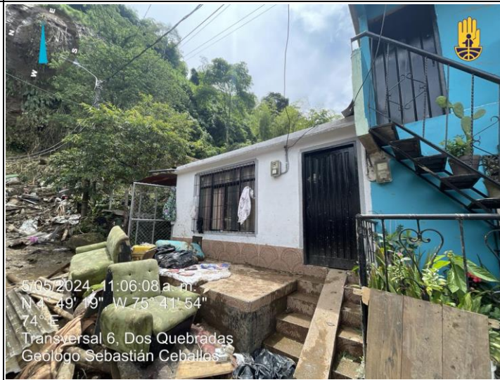
Foto 14. Fachada de la vivienda manzana L casa 05
