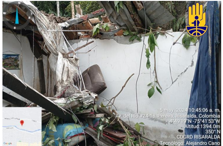
FOTO 2. Interior vivienda mz K casa 14
