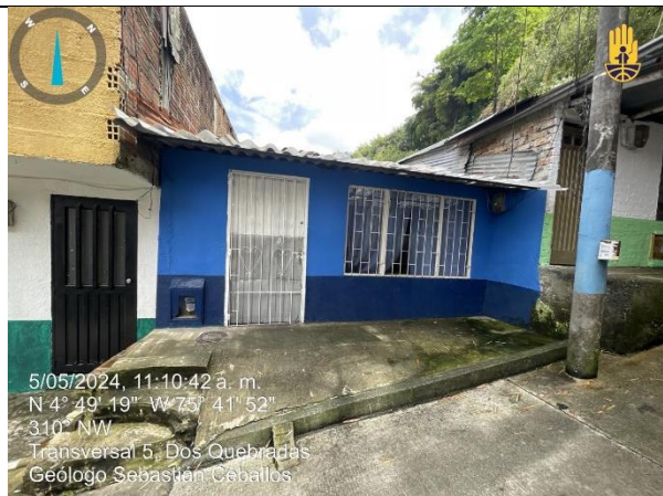
FOT 1. Fachada de vivienda Manzana L Casa 12 Barrio la Esneda Dosquebradas.
