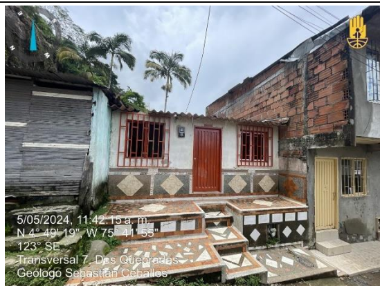
FOT 1. Fachada vivienda Manzana K casa 4 Barrio la Esneda Dosquebradas- Risaralda
