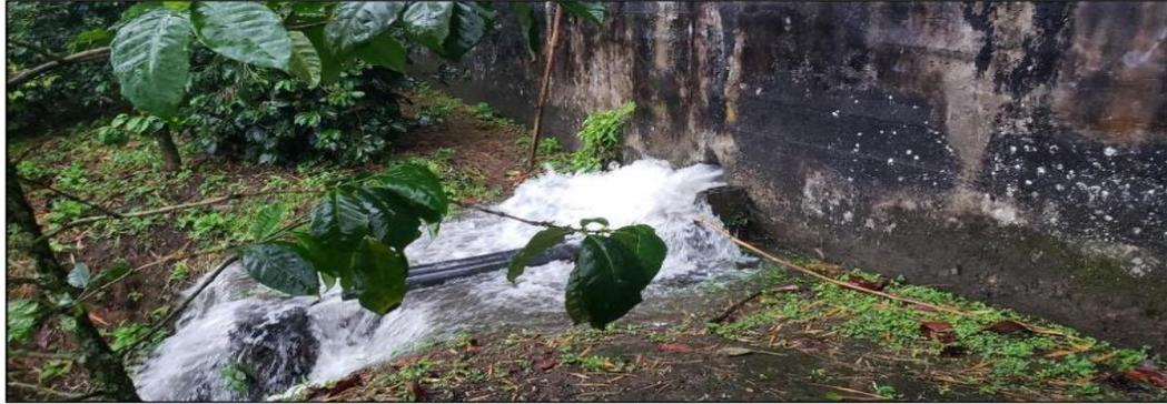
**Figura 16. Ruptura de la antigua canal de conducción de la Hidroeléctrica de Dosquebradas “Acequia”.**
