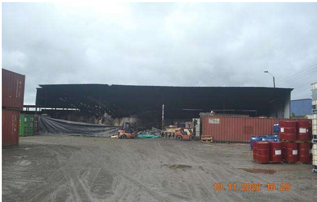
Se aprecia el cobertizo metálico, visiblemente afectado por el fuego.
