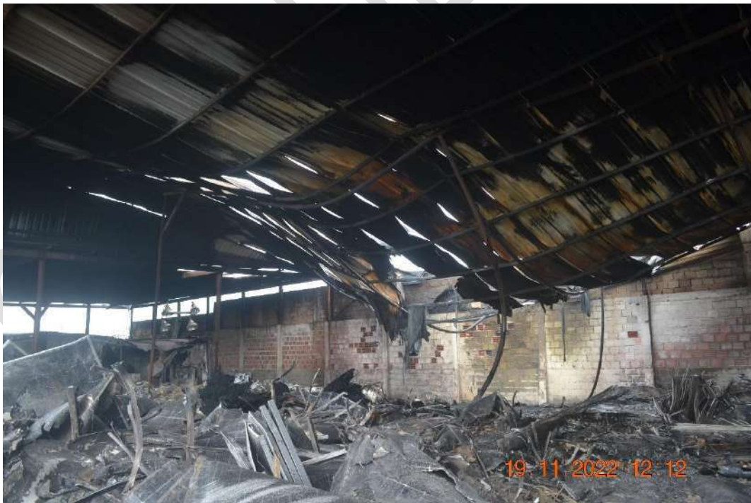
Se observa el estado de la cubierta del cobertizo metálico.
