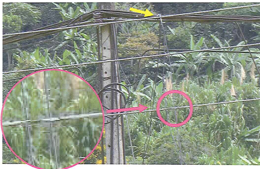
Ilustración 13. Detalle de la zona de corto-circuito
