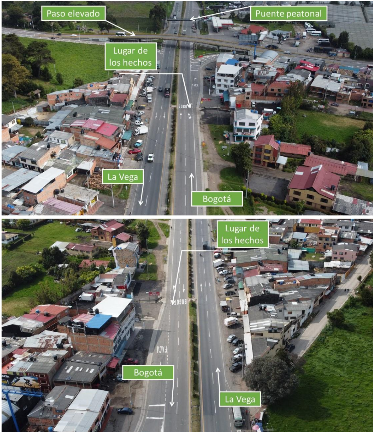
Fotografía No.5 Panorámica : En estas fotografías de vista aérea se aprecian las características generales de la vía donde ocurrió el accidente, “ nótese un puente peatonal a una distancia de 170 m del lugar de los hechos ”.
