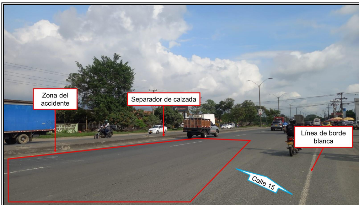
Imagen 2.5 Condiciones de la vía
