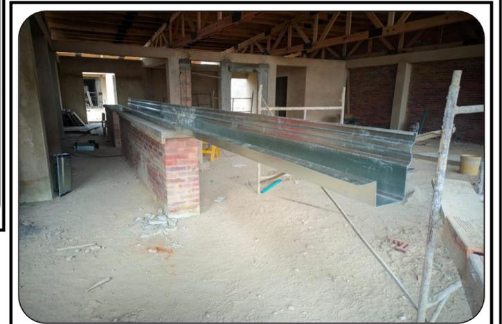
SOLDADURA PARA UNION DE CANALES PARA EL MODULO DE SUBESTACION ELECTRICA
