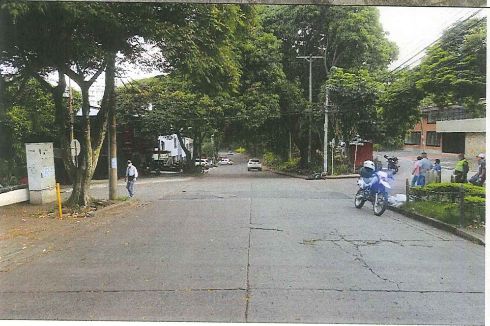
IMAGEN No. 03: PANORAMICA, donde se observa la avenida 8 norte sentido norte-sur (trayectoria del campero de placas UBX418), vía recta, plana, con andenes, de un sentido (norte-sur), con una calzada de 2 carriles en concreto bueno y seco, carente de demarcación vial; se observa en la esquina izquierda de fachada roja, un restaurante llamado PERU CHICKEN de donde se toma el video de cámara de seguridad como una de las evidencias, y los vehículos implicados (motocicleta con volcamiento lateral y campero blanco).
