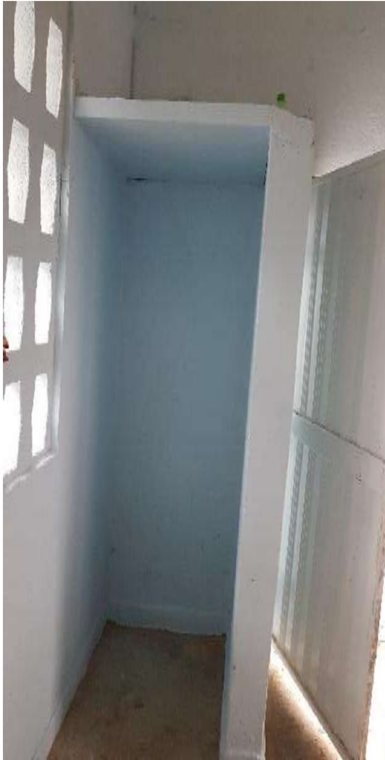
Foto. Adecuación de espacio para armario, encerrado con Súper Board.
