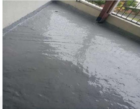
Una vez curado el material se realizó prueba de estanqueidad que dio resultado satisfactorio y dejando claro que la impermeabilización quedó bien ejecutada.
