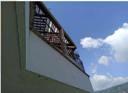
ARCE INGENIERÍA recomienda realizar un mantenimiento general de fachadas, flanches, solapas y alfajías en toda la edificación, pues el deterioro y fallas son evidentes y esto va a redundar en problemas de humedad al interior de los apartamentos.
