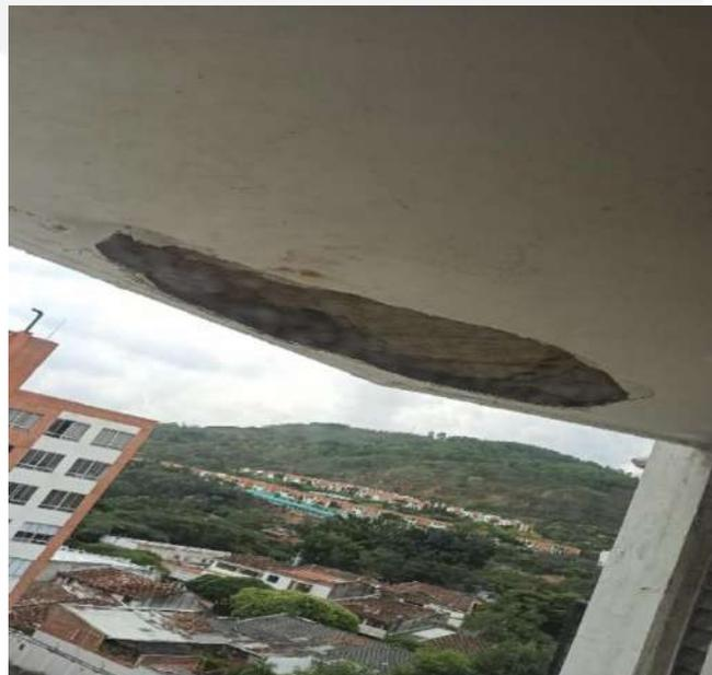
Se dejó la perforación realizada unos días abierta para evaluar su comportamiento y no hubo goteo de ningún tipo, aún con el balcón en funcionamiento y las tuberías con agua en su interior, este resultado se dio porque no llovió, pues cada que las lluvias se agudizan vuelve a suceder el fenómeno.
