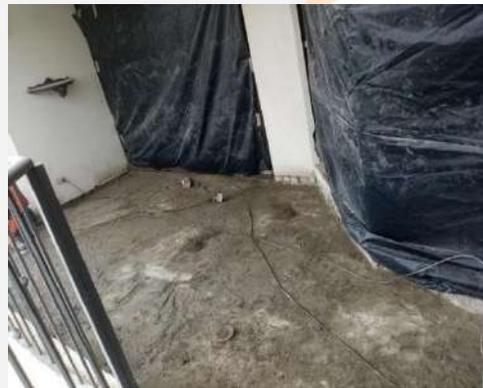
En la parte inferior de la losa se observaba una humedad que coincidía con el punto del desagüe, por lo que se procedió a impermeabilizar con poliuretano de alto desempeño **SISTEMA VULKEM 171 PRIMER + VULKEM 350**
