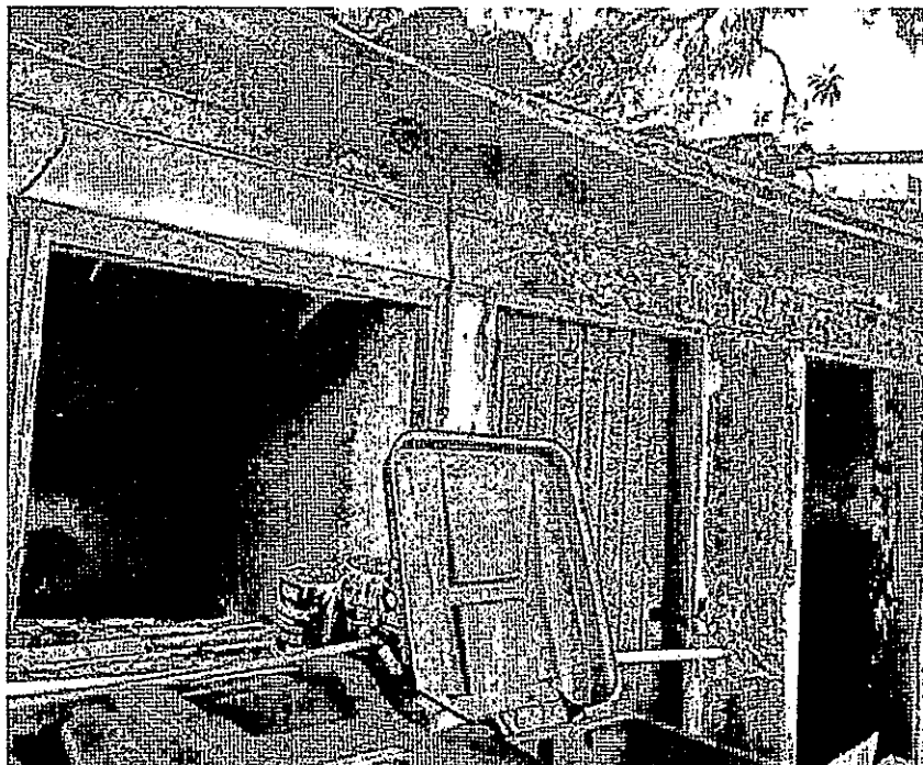
Figura 17. Humedad en muros y mal estado de cubierta.
