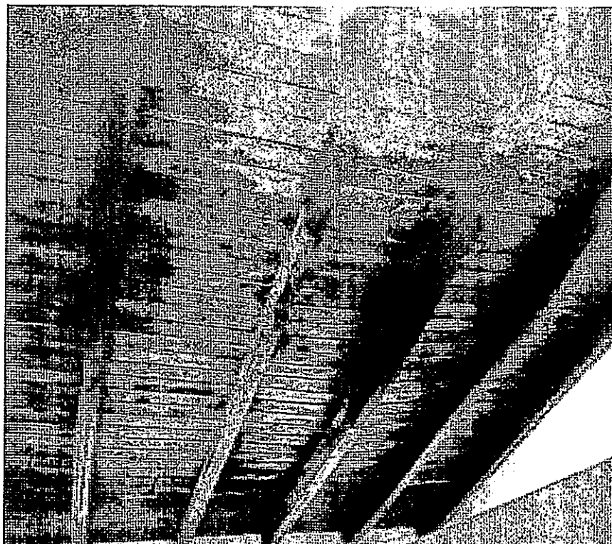
Figura 3. Humedad y deterioro de elementos de cubierta.
