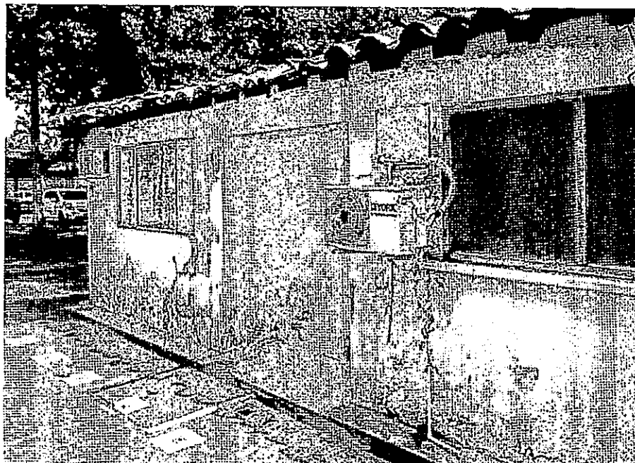
Figura 25. Humedad en muros externos de procedimiento.
