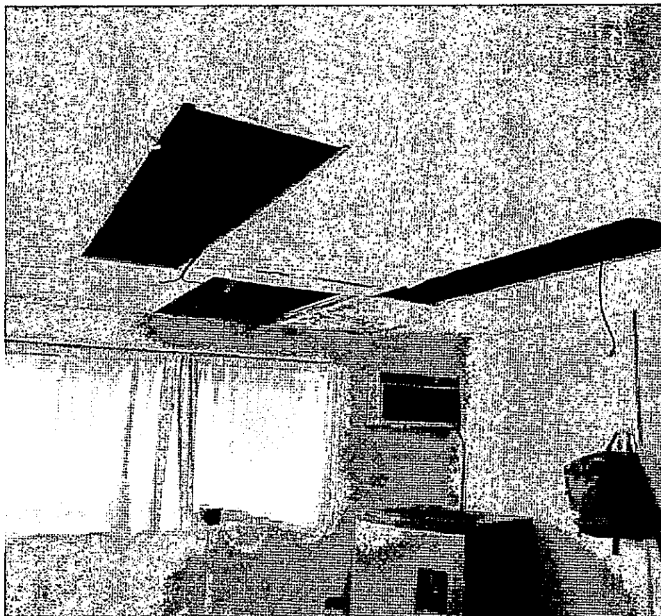
Figura 27. Mal estado de cielorraso.
