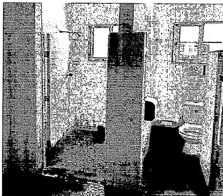
Figura 12. Deterioro de puertas en baños.
