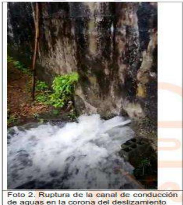
**Foto 2. Ruptura de la canal de conducción de aguas en la corona del deslizamiento**
